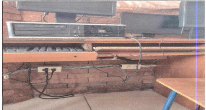
Foto 4: 19.12 Instalacion de unidades de fuerza, tomacorrientes dobles en área de computacion para corregir todas las instalaciones de fuerza. (Incluye sustitución de cableado y ducto eléctrico con sus respectivos)
