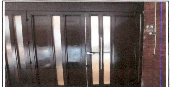
Foto 6: 4.2 Sustitucion de chapa, en el porton principal del estalecimiento por una chapa electrica. Colocando 70 mts de cable para poder abrir desde el area de oficinas.
