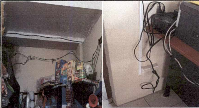
Foto 1: 17.12 Sustitución de cableado y ducto eléctrico + accesorios, en área de direcciones, bodegas, área de estar de maestros y tienda.
