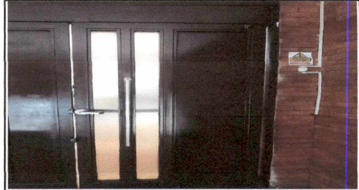
Foto 10: 17.12 Suministro e instalacion de Video Portero con pantalla a colores en ambas direcciones, incluye sustitucion de 70 ml de ducto electrico + accesorios, en area de patio, y cable #12 thhn.
