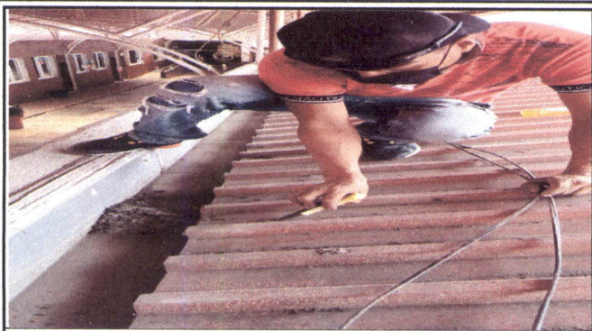
LIMPIEZA DE CANALES Y TECHO
