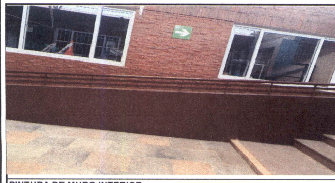
PINTURA DE MURO INTERIOR
