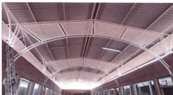
PINTURA DE TECHO INTERIOR
