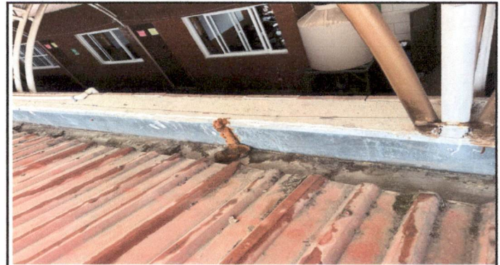
Foto 4: 3.3 SELLADO DE PUNTOS EXISTENTES DE TORNILLOS, JUNTAS Y MUROS VECINDARIOS
