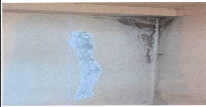
Foto 1: 9.1 PINTURA EN MUROS Y CIELOS DE INTERIORES DE SALONES, BODEGA, SECRETARIA, TIENDA Y VOLADIZOS
