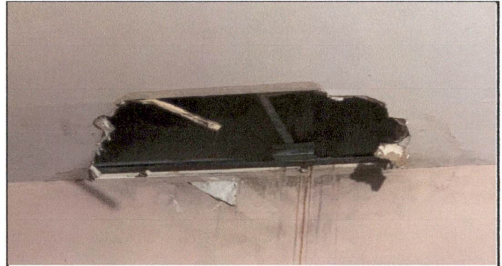
Foto 2: 3.2 REPACION DE CIELO FALSO EN TECHO DE VARIAS AULAS Y BODEGAS
