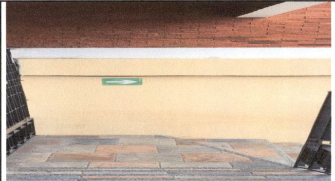
Foto 2: 9.1 PINTURA EN MURO Y CIELO DE EXTERIOR EN AREA DE INGRESO PEATONAL
