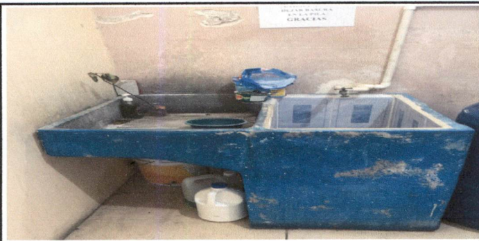
Foto1: SUSTITUCION DE PILA DE CEMENTO, LEVANTAMIENTO Y SACADO DE RIPIO
