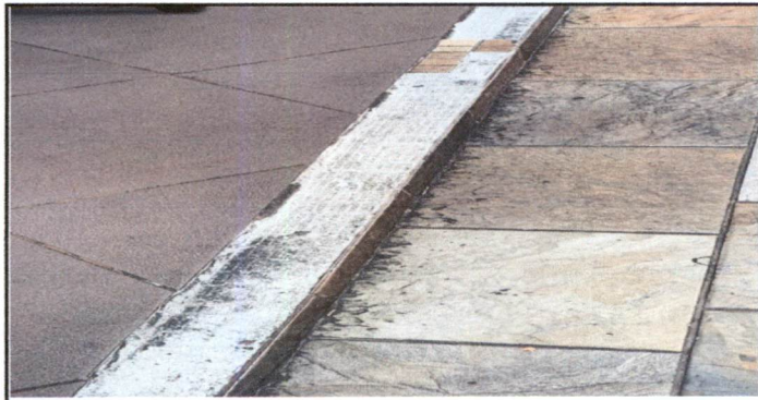
Foto 5: 6.8 SUSTITUCION DE PISO CERAMICO EN PASILLO
