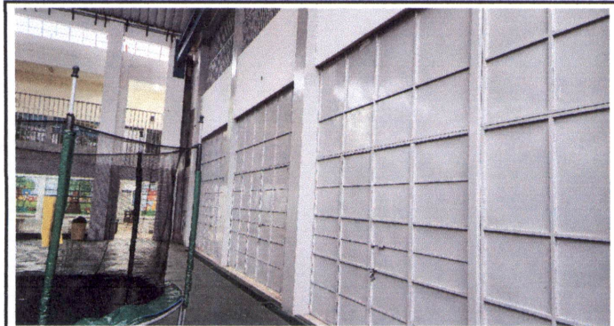
Foto 7: Pintura en muros exteriores e interiores
