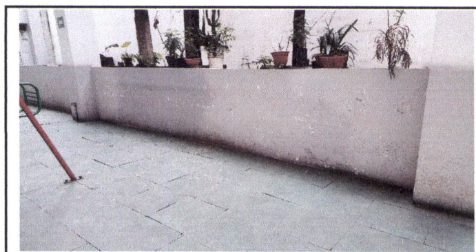
Foto 11: Pintura en muros exteriores e interiores
