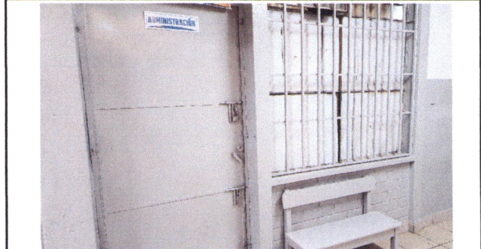
Foto 4: Sustitución de balcones
