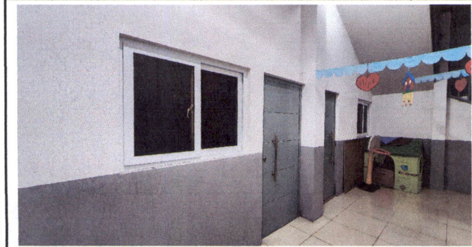
Foto 3: Sustitución de vidrio
