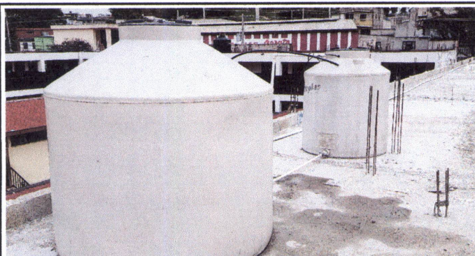
Foto 13: Sustitución de depósito de agua 1700 litros
