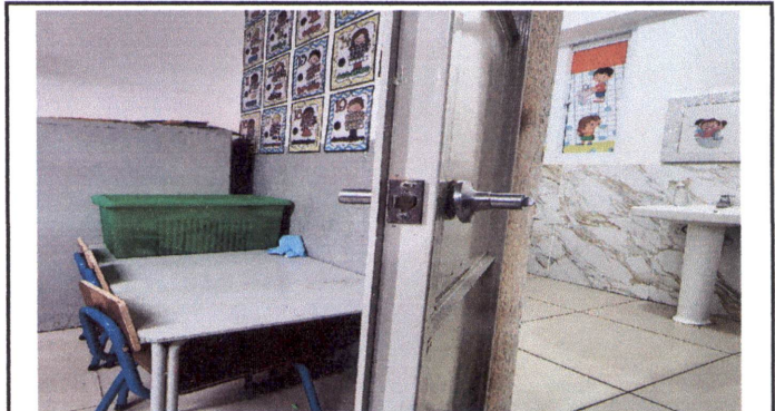
Foto 2: Sustitución de chapa
