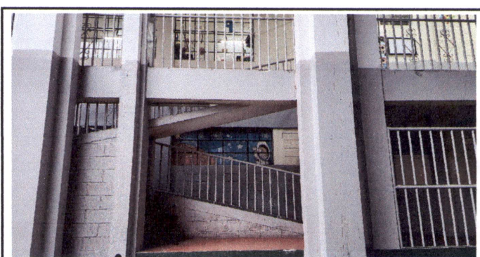
Foto 12: Pintura en muros exteriores e interiores
