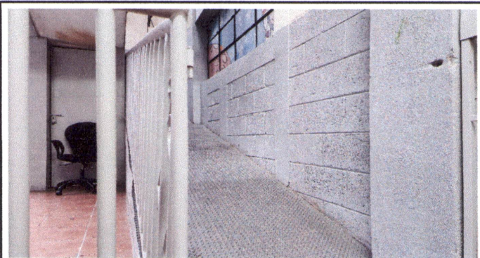
Foto 8: Mantenimiento a barandas de metal
