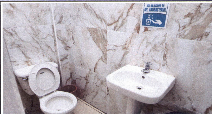
Foto 14: Instación de sanitarios
