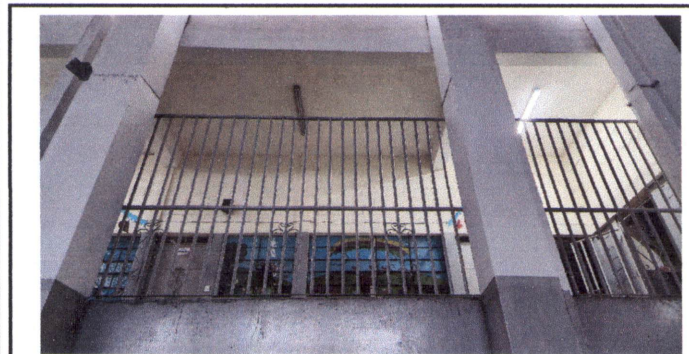
Foto 5: mantenimiento de balcones
