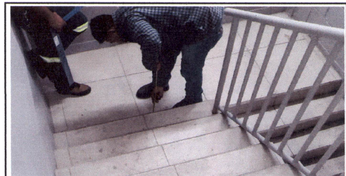
Foto 6: Sustitución de piso cerámico
