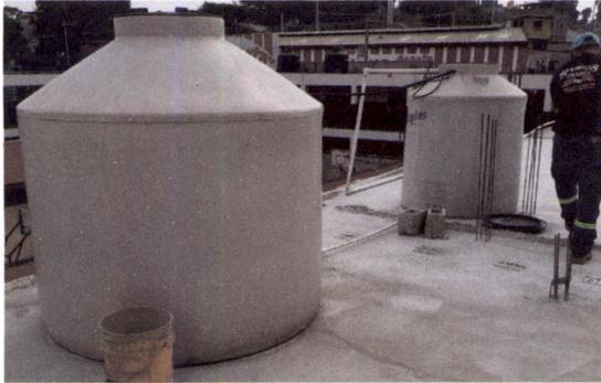
Foto 13: Sustitución de depósito de agua 1700 litros
