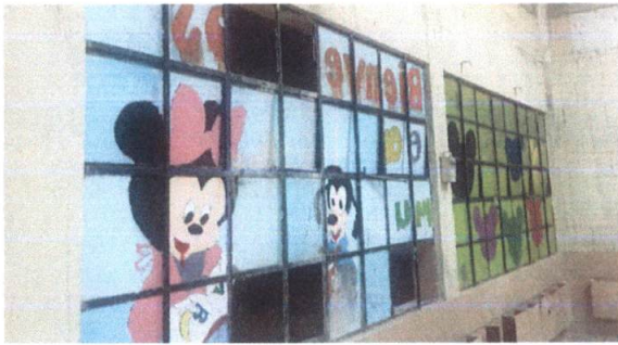
Foto 3: Sustitución de vidrio
