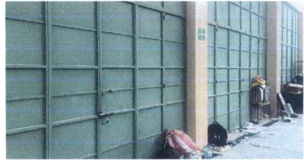
Foto 10: Mantenimiento a portones de metal
