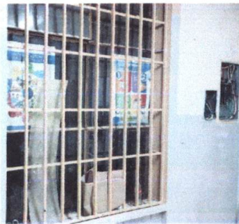
Foto 5: mantenimiento de balcones
