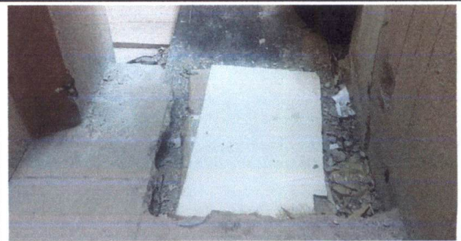
Foto 6: Sustitución de piso cerámico
