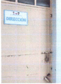
Foto 1: Mantenimiento a estructura (lijado, cambio de tubo , cepillado, sujeciones, aplicación de pintura)
