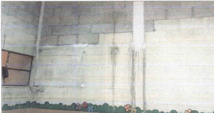
Foto 11: Pintura en muros exteriores e interiores
