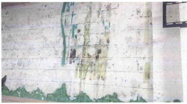
Foto 7: Pintura en muros exteriores e interiores
