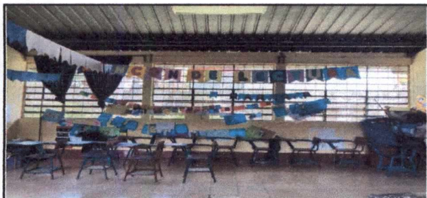
Foto 5: 5.1 MEJORAMIENTO A ESTRUCTURA DE METAL DE VENTANA (POR SEGURIDAD), INCLUYE INSTALACIÓN DE ESTRUCTURAS METALICAS ELABORADAS CON: (MALLA CALIBRE 13 CON TUBO TUBO DE 1 PULGADA CHAPA 16, PENSADO CON PLANO 3/16 POR 1/2 CON MEDIDAS DE 2.30 M. DE ANCHO POR 1.75 M. DE ALTO.
