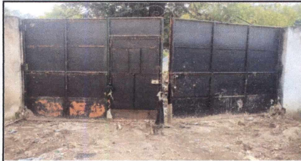
Foto 25: 19.23 IMPLEMENTACIÓN DE RAMPA EN PORTÓN DE INGRESO SECUNDARIO, INCLUYE ELABORACIÓN DE BASE DE CONCRETO CON UN GROSOR DE 10 CMS. (CON CONCRETO DE 5800 PSI Y ELECTROMALLA). DIMENSIONES 5 MTS DE ANCHO X 2.40 MTS. DE LARGO
