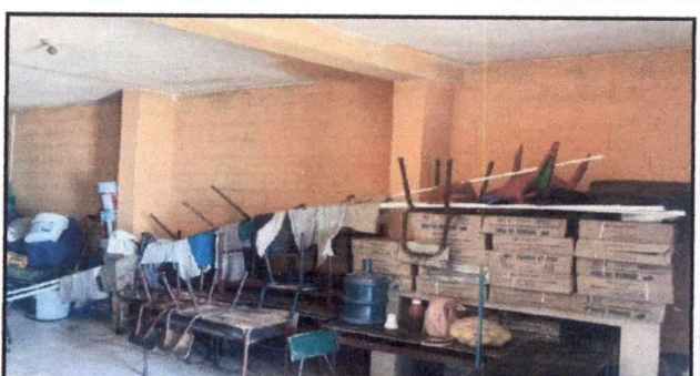
Foto 16: 13.1 INSTALACIÓN DE AZULEJO EN COCINA (YA SE CUENTA CON EL AZULEJO PARA INSTALAR, EL RENGLÓN SÓLO INCLUYE MANO DE OBRA Y MATERIAL PARA CIZA Y PARA PEGAR AZULEJO)
