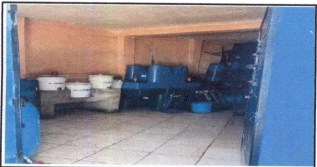
Foto 17: 13.1 INSTALACIÓN DE AZULEJO EN COCINA (YA SE CUENTA CON EL AZULEJO PARA INSTALAR, EL RENGLÓN SÓLO INCLUYE MANO DE OBRA Y MATERIAL PARA CIZA Y PARA PEGAR AZULEJO)
