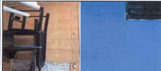
Foto 23: 19.2 SUMINISTRO E INSTALACIÓN DE BALCÓN DE METAL (INCLUYE APERTURA Y TALLADO DE VANO PARA VENTANA) EN COCINA, MEDIDAS 1.00 X 1.00 MTS
