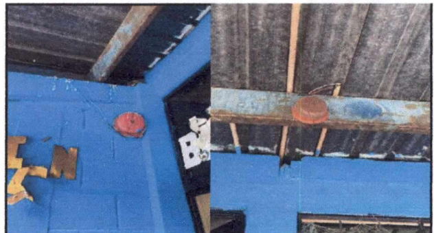
Foto 22: 17.13 INSTALACIÓN DE TIMBRE, INCLUYE TIMBRE Y MATERIALES
