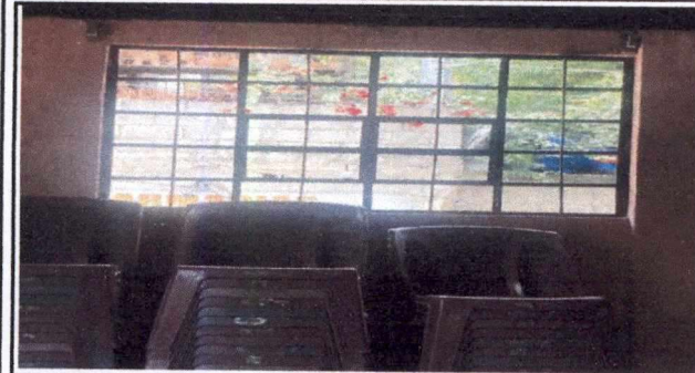
Foto 13: 5.6 INSTALACIÓN DE BALCÓN DE METAL (MEDIDAS:1.37 MTS. X 1.04 MTS.) EN DIRECCIÓN
