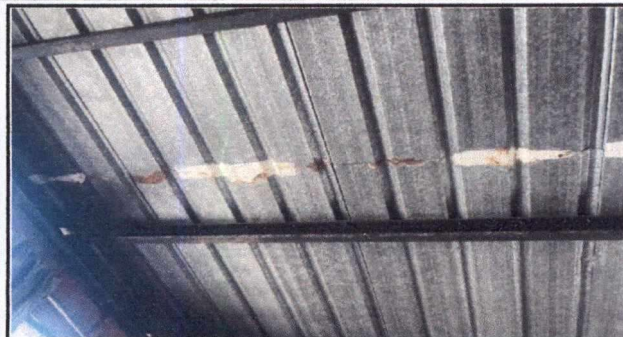
Foto1: 1.1 SUSTITUCIÓN DE LÁMINA POR LÁMINA TROQUELADA ALUZINC CALIBRE 26 (EN DIRECCIÓN)
