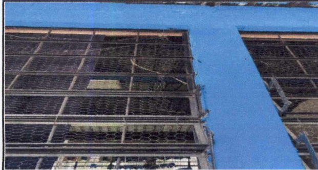
Foto 7: 5.1 MANTENIMIENTO A ESTRUCTURA DE METAL DE VENTANA, INSTALACIÓN DE ESTRUCTURAS METÁLICAS ELABORADAS CON: (MALLA CALIBRE 13 CON TUBO TUBO DE 1 PULGADA CHAPA 16, PRENSADO CON PLANO 3/16 POR 1/2 CON MEDIDAS DE 2.30 M. DE ANCHO POR 1.35 M. DE ALTO. EN AULAS
