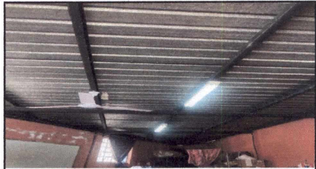
Foto 2: 1.1 SUSTITUCIÓN DE LÁMINA POR LÁMINA TROQUELADA ALUZINC CALIBRE 26 (EN DIRECCIÓN)
