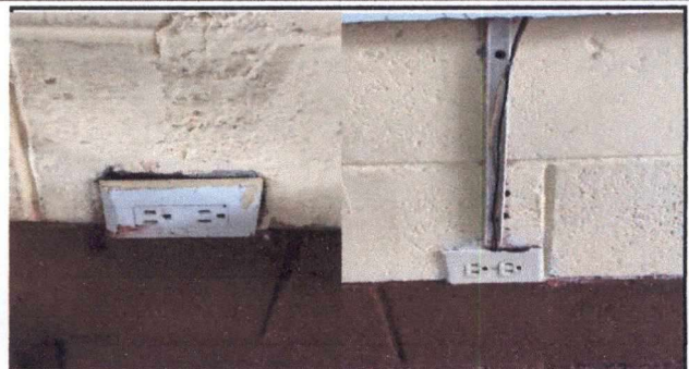
Foto 20: 17.8 SUSTITUCIÓN DE TOMACORRIENTES DOBLES, INCLUYE SUSTITUCIÓN DE CABLEADO Y DUCTO ELÉCTRICO CON ACCESORIOS
