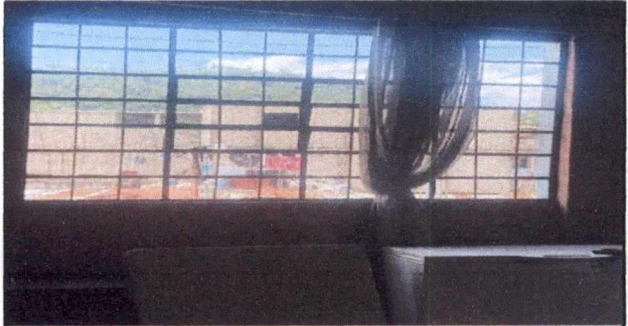
Foto 12: 5.6 INSTALACIÓN DE Balcón DE METAL (MEDIDAS: 2.06 MTS. X 1.60 MTS.) EN DIRECCIÓN
