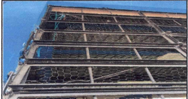
Foto 8: 5.1 MANTENIMIENTO A ESTRUCTURA DE METAL DE VENTANA, INSTALACIÓN DE ESTRUCTURAS METÁLICAS ELABORADAS CON: (MALLA CALIBRE 13 CON TUBO TUBO DE 1 PULGADA CHAPA 16, PRENSADO CON PLANO 3/16 POR 1/2 CON MEDIDAS DE 1.12 M. DE ANCHO POR 1.35 M. DE ALTO. EN AULAS
