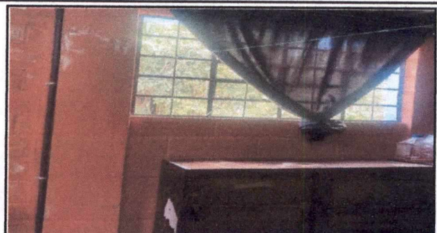
Foto 14: 5.6 INSTALACIÓN DE BALCÓN DE METAL (MEDIDAS:1.37 MTS. X 1.04 MTS.) EN DIRECCIÓN
