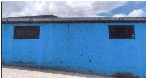
Foto 27: 21.1 RESANADO DE MURO EXTERIOR POR HUMEDAD: INCLUYE LIMPIEZA DE MURO, APLICACIÓN DE IMPERMEABILIZANTE ELASTOMÉRICO CON RECINAS ACRÍLICAS FLEXIBLES, APLICACIÓN DE REPELLO Y ALISADO
