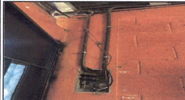
Foto 21: 17.11 SUSTITUCIÓN DE TABLERO ELÉCTRICO (4 CIRCUITOS 125 AMPERIOS TL412) INCLUYE INSTALACIÓN DE FLUPÓN DE 20 AMPERIOS Y SUSTITUCIÓN DE CABLEADO DESDE ACOMETIDA CON CABLE THHN/THWN CALIBRE 6
