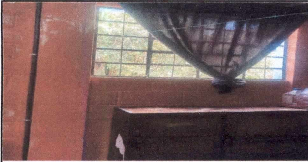
Foto 11: 5.2 SUSTITUCIÓN DE VENTANA POR VENTANA DE PVC CORREDIZA (MEDIDAS: 1.37 MTS. X 1.04 MTS.) EN DIRECCIÓN
