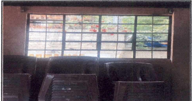
Foto 10: 5.2 SUSTITUCIÓN DE VENTANA POR VENTANA DE PVC CORREDIZA (MEDIDAS: 1.37 MTS. X 1.04 MTS.) EN DIRECCIÓN
