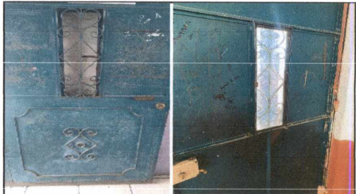
Foto 2: Mantenimiento, lijado y pintado de puertas de salones de clase
