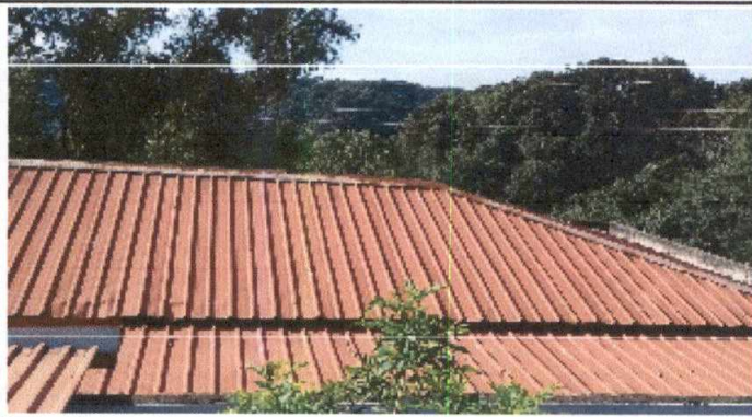
Foto 3: Instalacion y sellado de capote del salon de audiovisuales
