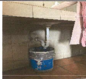
Foto 6: Instalacion de contrallaves para lavamanos
