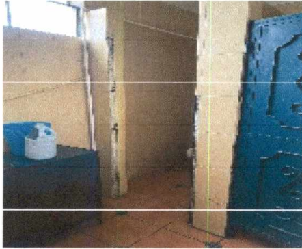
Foto1: Reparacion de marcos e instalacion de bisagras puerta de sanitarios
