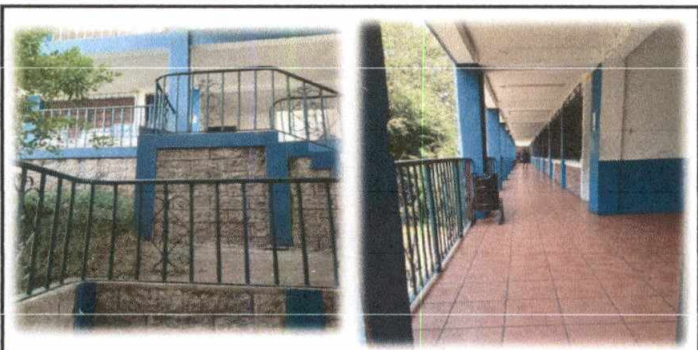
Foto 5: Pintura de barandas y pasamanos
