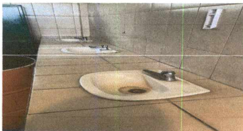
Foto 5: Instalación de grifos para lavamanos
