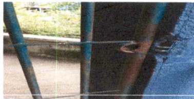
Foto 3: Mantenimiento y reparación de porton de reja Modulo 3
