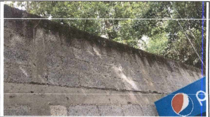
Foto 4: Fabricación e instalacion de estructura de maya y tubo galvanizado
