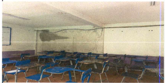
Foto 2: Impermeabilización de salones de clase y bodega
