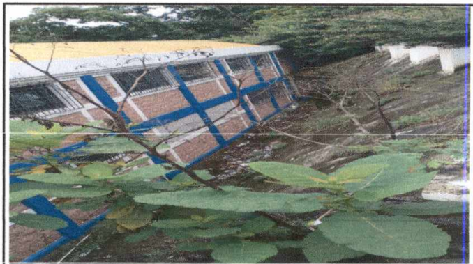
Foto 4: Impermeabilización y limpieza de paredes exteriores y muro de contension
