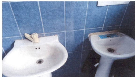
FOTO: Sustitución de mezcladora de lavamanos, (Contrallave y tubo de abasto)
