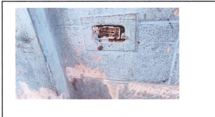
FOTO 8 : Sustrucción de tomacorrientes dobles
