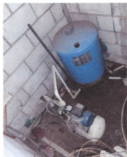
FOTO 2: Sustitución de bomba de agua
