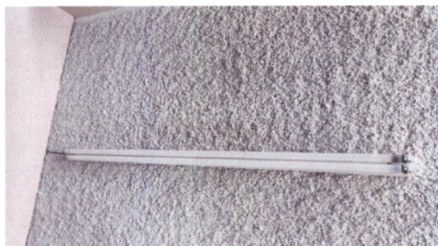
FOTO 5: Sustitución de lámparas tipo led
