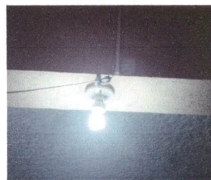
FOTO 6: Sustitución de plafoneras
