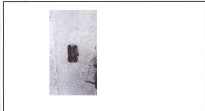
FOTO 7: Sustrucción de interruptores simples
