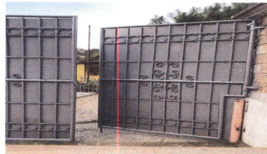
Foto12: Mantenimiento a porton de metal
