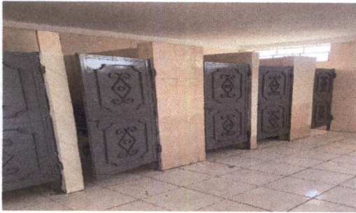
Foto 1: Mantenimiento a la estructura de las puertas
