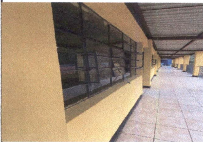
Foto 5: Sustitución de estructura de metal de ventanas
