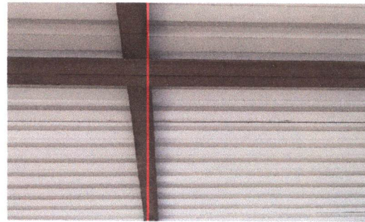
Foto 4: Sustitución de capote de lamina para lamina troquelada
