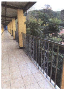
Foto 11: Mantenimiento a barandas de metal
