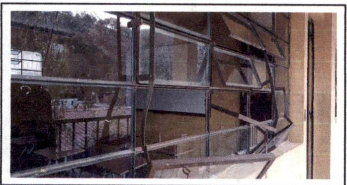
Foto 5: Sustitución de estructura de metal de ventanas
