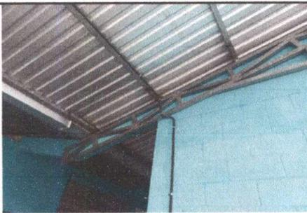
FOTO 5: SUSTITUCIÓN DE DUCTO Y CABLEADO ELÉCTRICO
