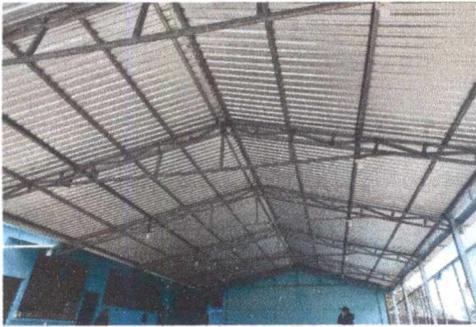
FOTO 1: SUSTITUCIÓN DE ESTRUCTURA DE SOPORTE DE METAL
