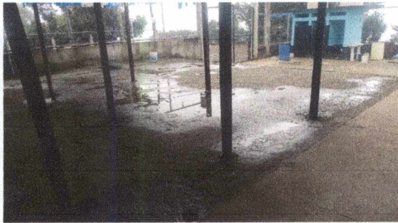
Foto 3: losa de patio ( Reparación de plancha de concreto de patio )
