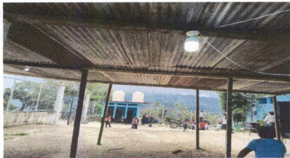
Foto 5: Reparación de sistema eléctrico
