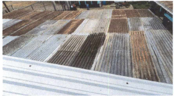
Foto 4: estructura de techo , canales y agua pluvial
