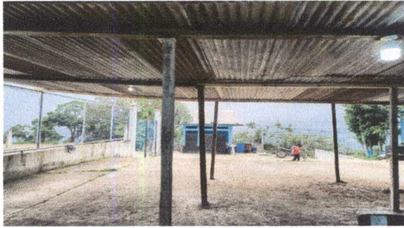
Foto1: Sustitucion de estructura de soporte de madera por metal
