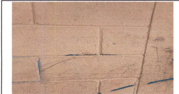
foto. 3 pintura en muros exteriores y interiores
