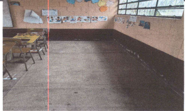
foto. 2 sustitucion de piso ceramico
