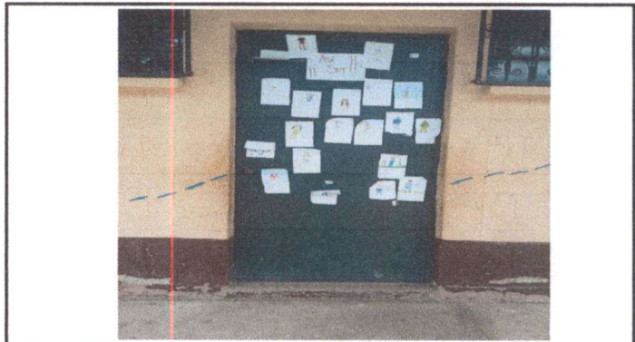
foto.4. mantenimiento a estructura de puertas de metal
