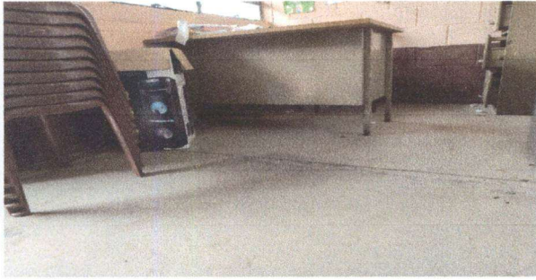
Foto . 1 Sustitución de piso ceramico
