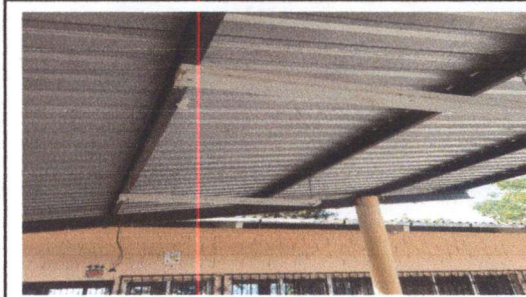
foto. 2 sustitución de cableado eléctrico + accesorios
