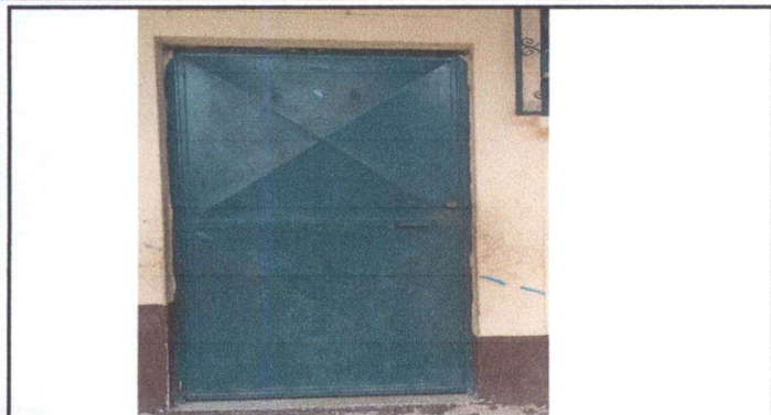
foto. 1 mantenimiento a estructura de puertas de metal
