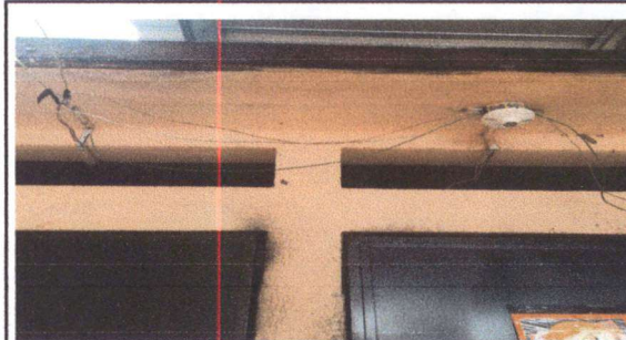
foto. 4 sustitución de cableado eléctrico + accesorios
