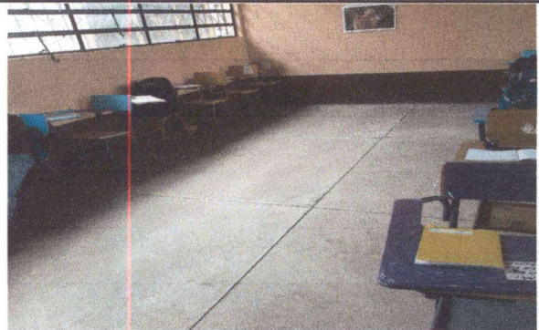
foto. 4 sustitucion de piso ceramico
