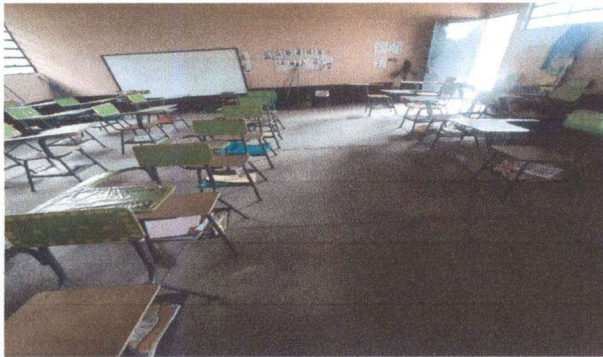
foto. 3 sustitucion de piso ceramico
