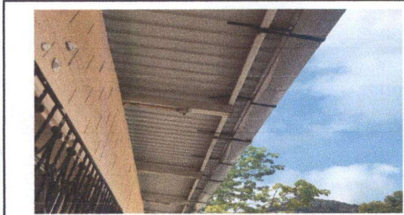
foto. 1 sustitución de cableado eléctrico + accesorios
