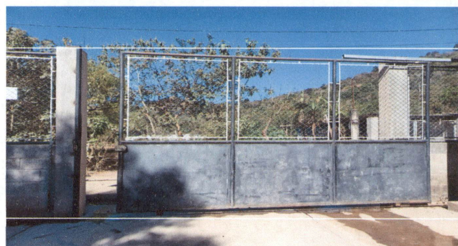
Foto 8: Reparación de portón
