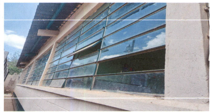
Foto 9: Cambio de vidrios
