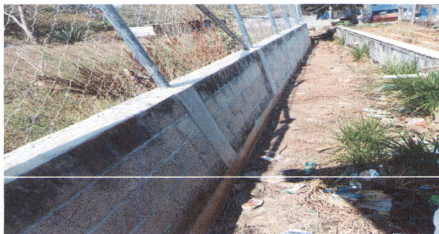
Foto 3: cuneta donde corre agua pluvial
