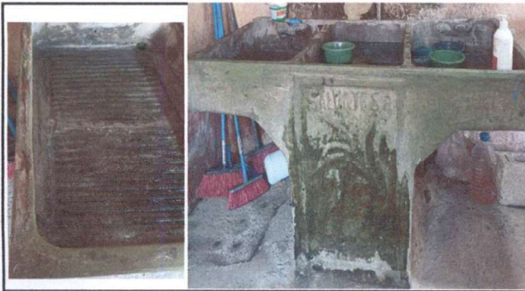
Foto 3: Sustrucción de pila de cemento de dos lavadero
