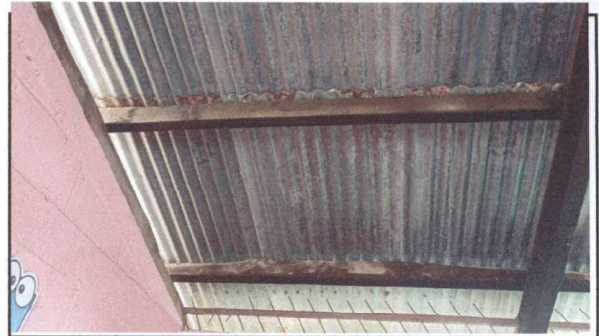
Foto 4: Sustrucción de lámina, por lámina troquelada aluzinc calibre 26
