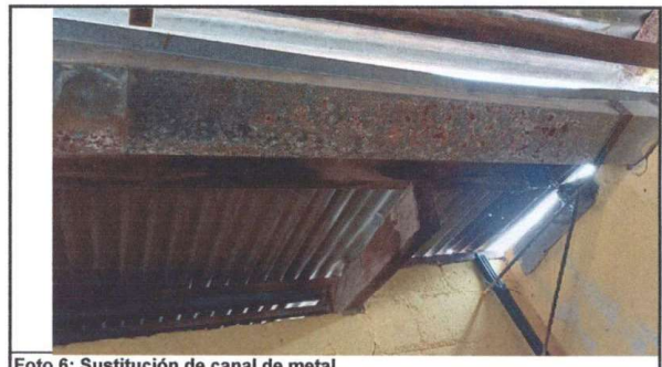
Foto 6: Sustrucción de canal de metal
