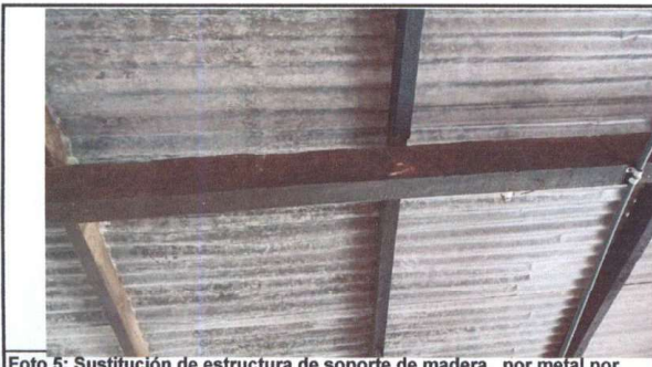
Foto 5: Sustrucción de estructura de soporte de madera, por metal por encontrarse en muy mal estado.
