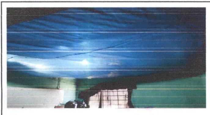
Sustitución de lámina por lámina alucing Calibre 26
