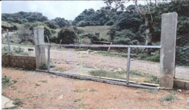
Foto 1: Sustrucción de portón principal de metal
