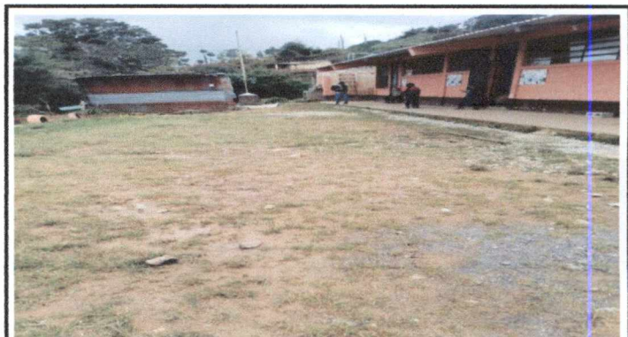
Foto 4: Sustrucción e instalación de piso de torta frontal
