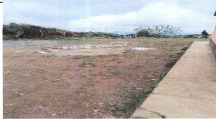
Foto 3: Sustrucción e instalación de piso de torta lateral
