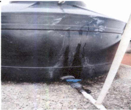
Foto 5: Sustrucción de agua 1,100 lts
