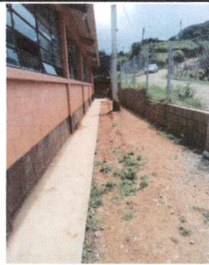
Foto 2: Sustrucción e instalación de piso de concreto
