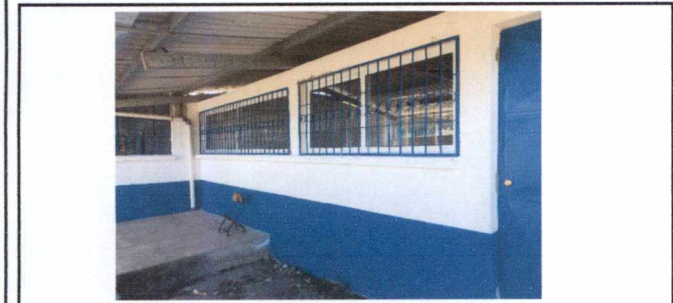
FOTO 3: SUMINISTRO E INSTALACIÓN DE BALCONES DE METAL EN AULA
