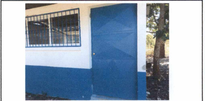
FOTO 2: SUMINISTRO E INSTALACIÓN DE PUERTA DE METAL EN AULA
