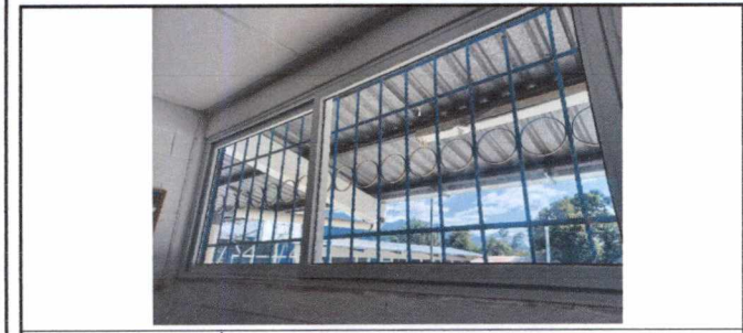
FOTO 5: SUSTITUCIÓN DE VENTANAS POR VENTANAS PVC CORREDIZAS
