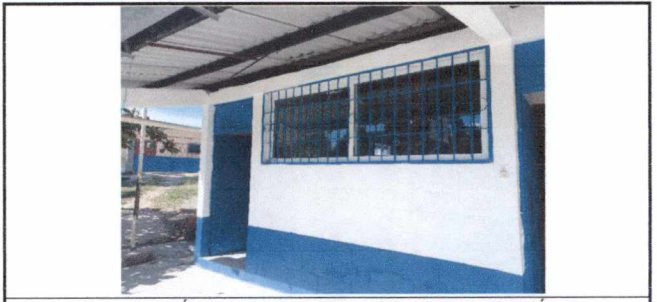
FOTO 6: SUSTITUCIÓN DE BALCONES DE METAL Y APLICACIÓN DE PINTURA EN MUROS
