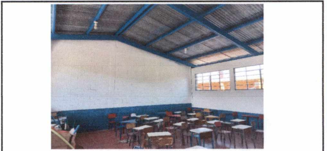
FOTO 4: APLICACIÓN DE PINTURA EN MUROS
