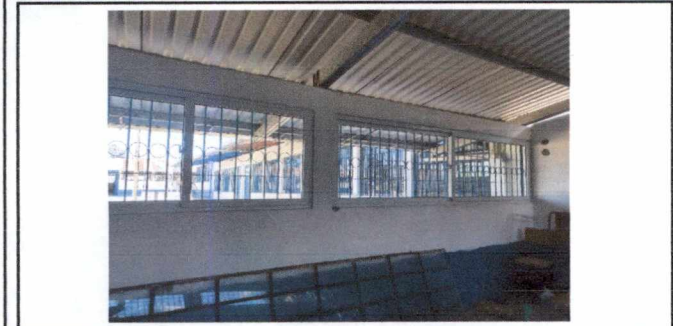
FOTO 1: SUMINISTRO E INSTALACIÓN DE VENTANAS DE PVC CORREDIZAS EN AULAS
