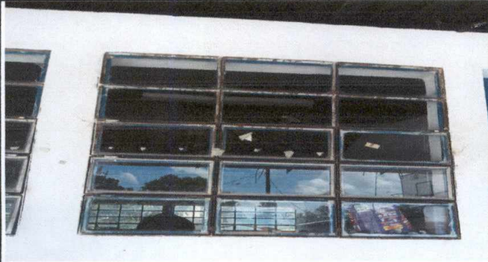
Foto 1: Sustitución de Ventana hierro por una ventana de Pvc corrediza, se realiza la sustitución por falta de ventilación de las ya existentes.
