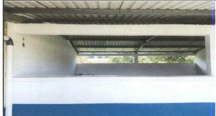
Foto 8: Instalación de Ventana de pvc corrediza y Balcon de hierro para protección del salón y poderlo habilitar.
