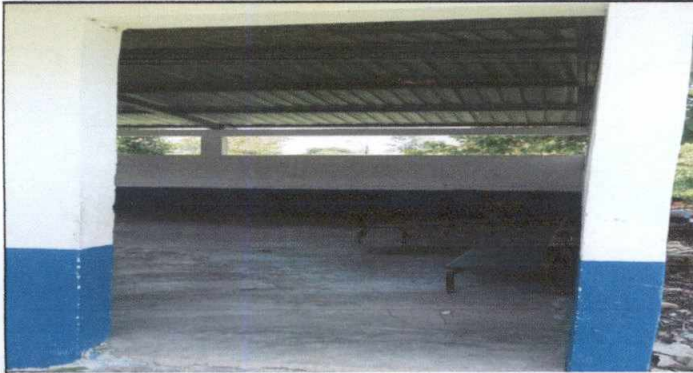
Foto7: Instalación de puerta de metal en salón de clases que no cuenta con la misma para seguridad del salón y poderlo utilizar y ampliar nuestra cobertura
