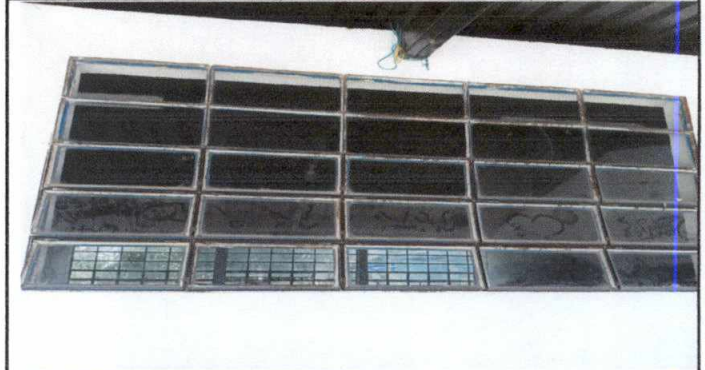
Foto 2: Sustitución de Ventana hierro por una ventana de Pvc corrediza, se realiza la sustitución por falta de ventilación de las ya existentes.
