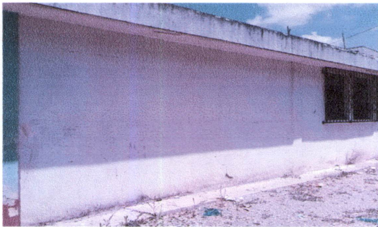
Foto 8: Repello y alisado de paredes gretadas de la parte lateral del lado derecho, entrada principal.
