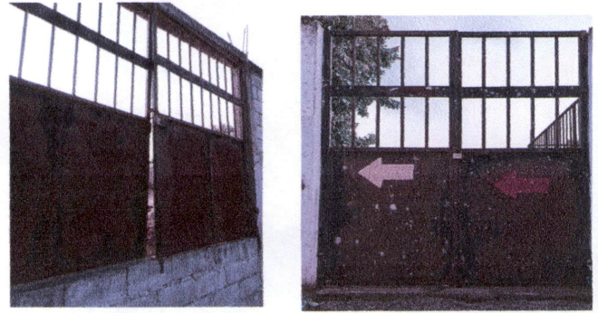
Foto 2: Sustitución de portones, parte trasera del centro educativo y parte frontal.
