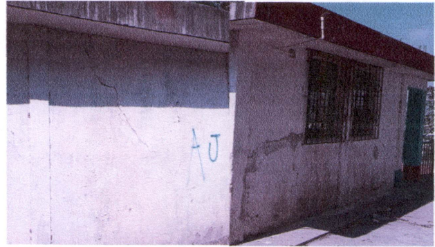
Foto 8: Repello y alisado de paredes gretadas de la parte lateral izquierda, donde esta el porton de la parte de atrás.
