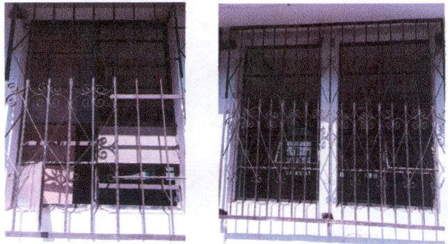
Foto 4: sustitución de vidrios con vidrio enmallado, y mantenimiento de balcones.
