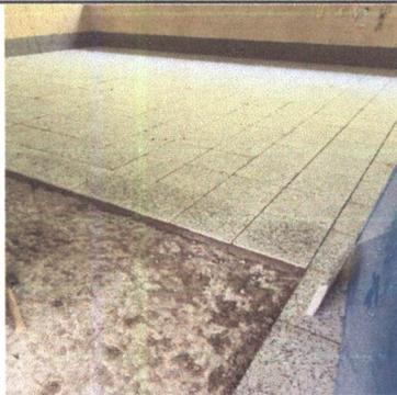
Foto 3: Cambio de piso de concreto a piso de granito, para un ambiente mas adecuado.
