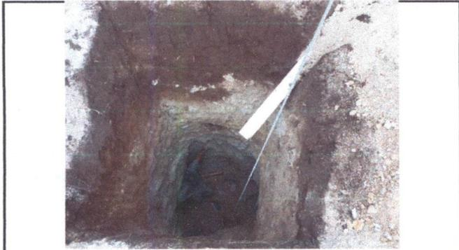
Foto 7: sustitución de fosa séptica para el funcionamiento de los servicios sanitarios.
