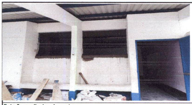
Foto 5: ampliacion de ventanas
