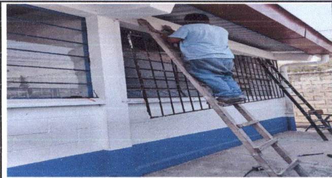
Foto 4: sustitución de vidrios en mal estado y reparacion de ventanas
