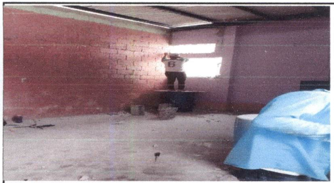
Foto 3: ampliacion de ventanas de aula de preparatoria
