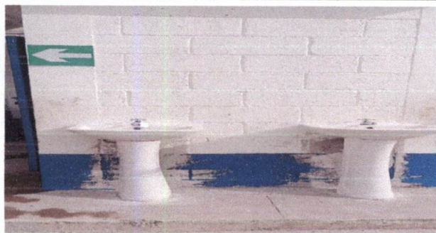
Foto 5 :instalación de lavamanos
