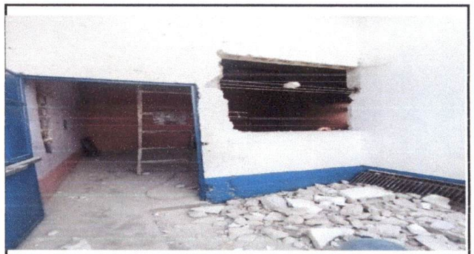
Foto 4: ampliacion de ventanas de aula de preparatoria
