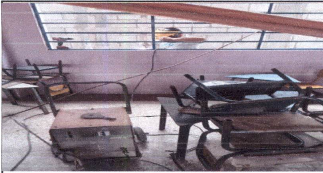
Foto 3: reparacion de ventanas en mal estado
