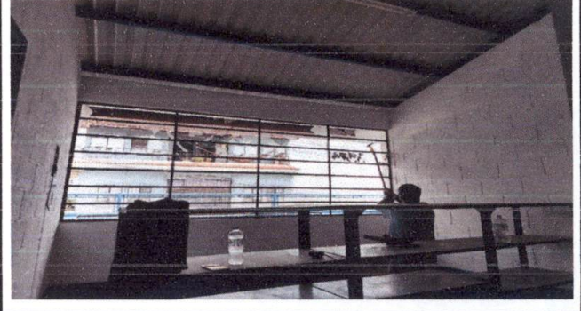
Foto 2: reparacion de ventana y sustitución de vidrios.
