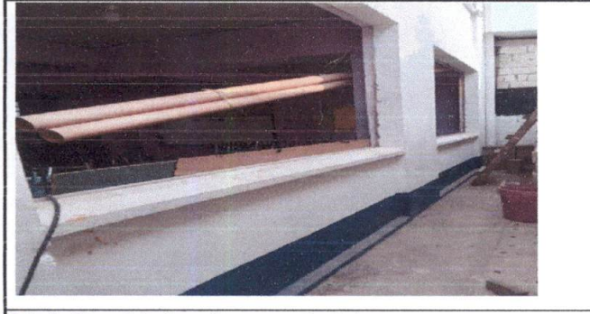
Foto 5: Desmotaje de ventanas en mal estado
