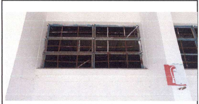
Foto 2: se realizara sustitución de ventana y colocación de vidrios
