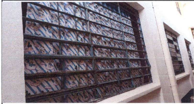
Foto1: se trabajara mantenimiept a ventanas y sustitución de vidrios
