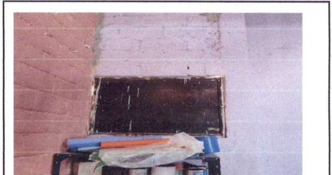
Foto 4: se trabajara fabricación de ventana de metal
