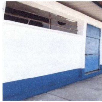
Foto 2: reparación de ventana y sustitución de vidrios.
