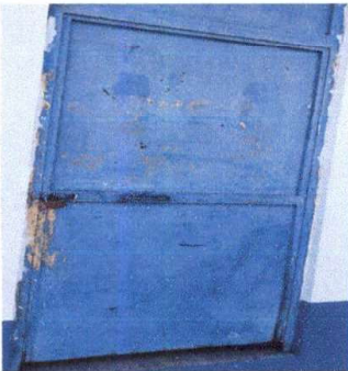
Foto 3: fabricación de puerta
