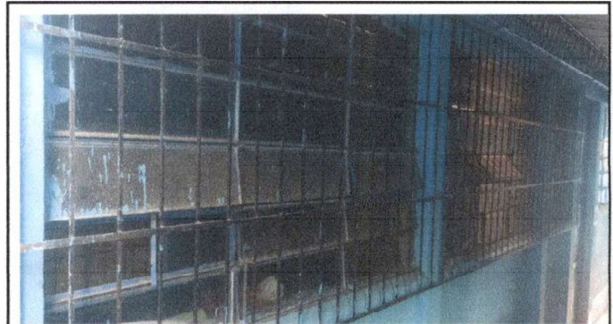
Foto 4: Lijado y pintura a balcones.
