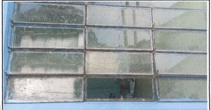
Foto 2: Lijado y pintura a ventanales.
