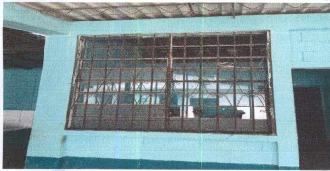
Foto1: Se cambiara todo el ventanal parte de la bodega
