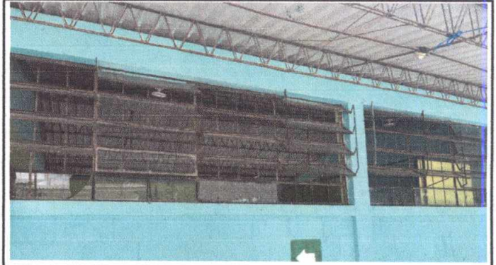
Foto 2: se cambiara todo el ventanal parte de direccion .
