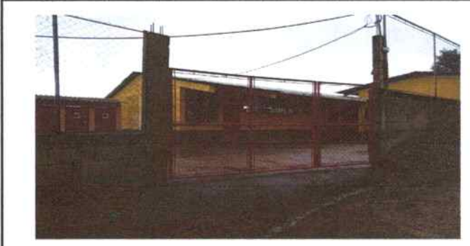
4. Desinstalación, ampliación e instalación de portón de ingreso
