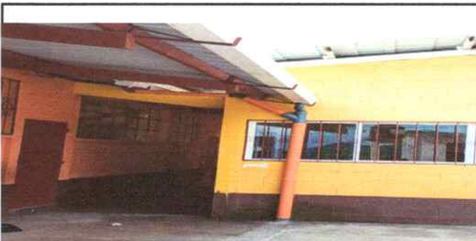
6. Sustitución e instalación de canal de metal con bajadas de agua de pvc
