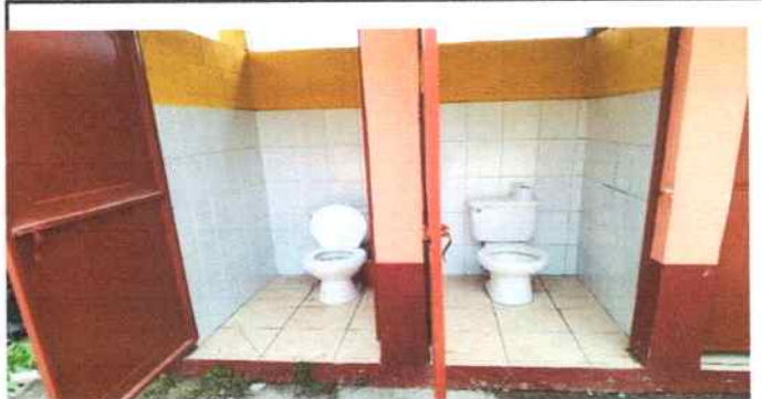
8. Instalación de inodoros con su tubería de agua
