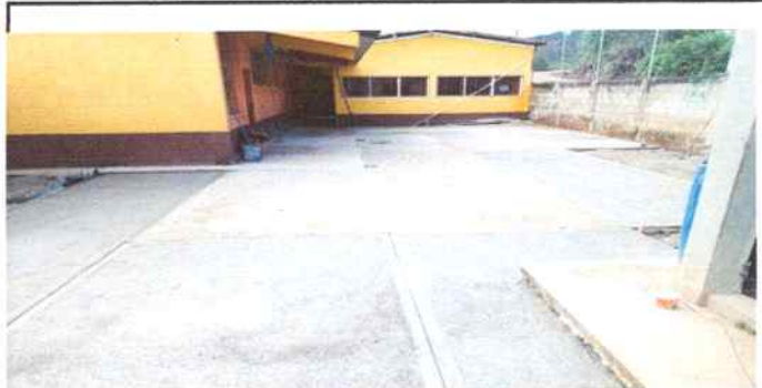
3. fabricación de planchas de concreto
