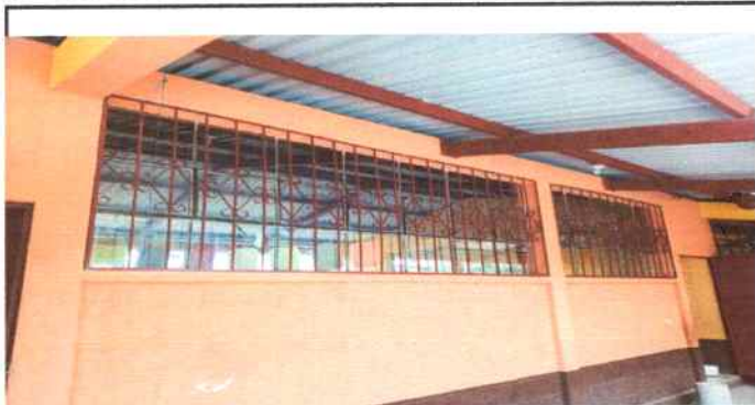
1. Fabricación e instalación de balcones de hierro
