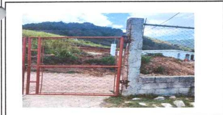
5. Demoler, reubicar y fundir columna de concreto para porton de ingreso
