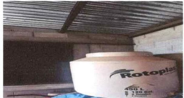
10. Instalación de un depósito de agua dentro de cocina
