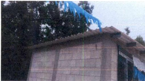
Foto 3: Suministro e instalación de canal de metal con pescantes
