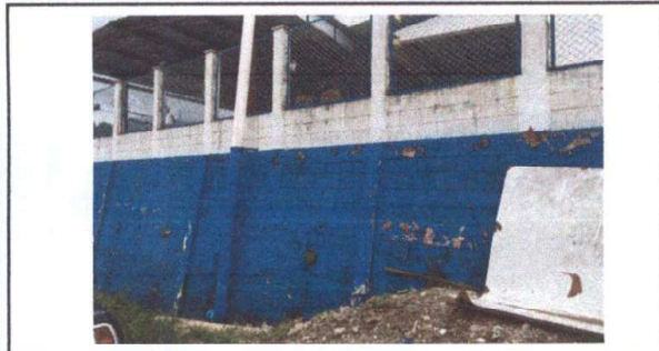
Esta fotografía muestra la parte frontal del perímetro del establecimiento, en el cual la pintura se observa que se está despegando.
