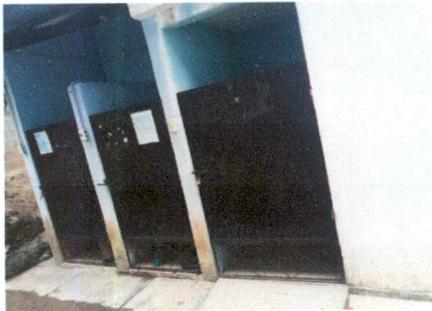
Foto 5: Lijado, pintura y reparación de parte inferior de de las 6 puertas del sanitario.
