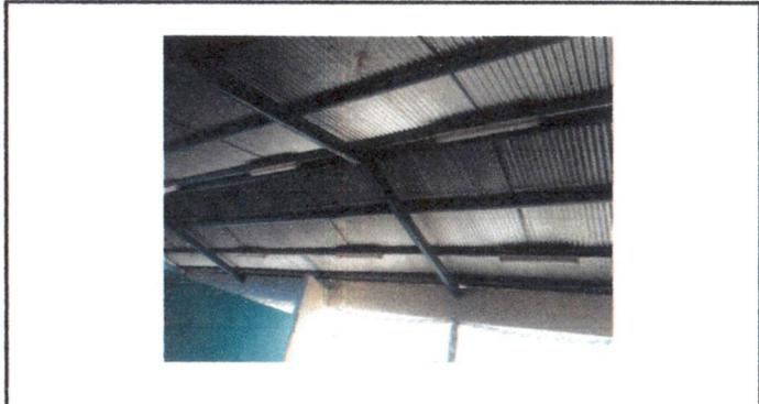
Foto 4: Pintura de techo exterior de 6 aulas, dirección y biblioteca, cocina. Incluye sellado de tornillos, limpieza y pintura de estructura metálica.
