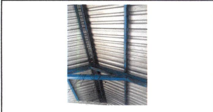
Foto 3: Pintura de techo exterior de 6 aulas, dirección y biblioteca, cocina. Incluye sellado de tornillos, limpieza y pintura de estructura metálica.
