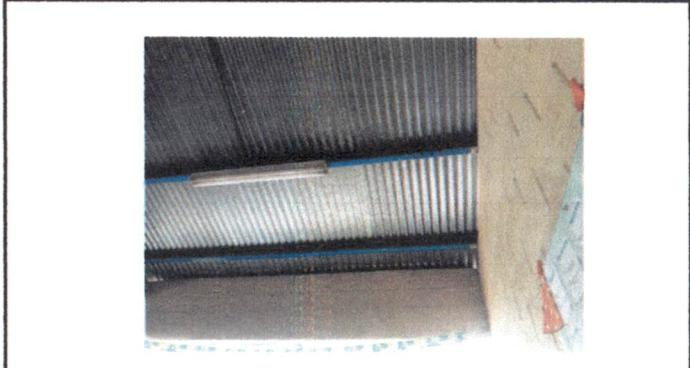
Foto 2: Pintura de techo exterior de 6 aulas, dirección y biblioteca, cocina. Incluye sellado de tornillos, limpieza y pintura de estructura metálica.
