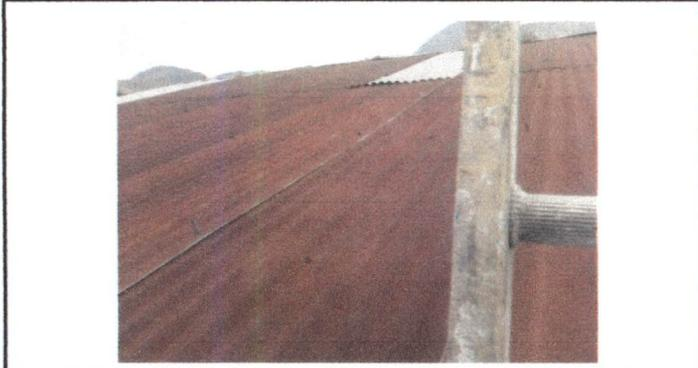
Foto 1: sustitución de lámina por lámina troquelada aluzinc calibre 26 prepintada R/B en 1 aula virtual
