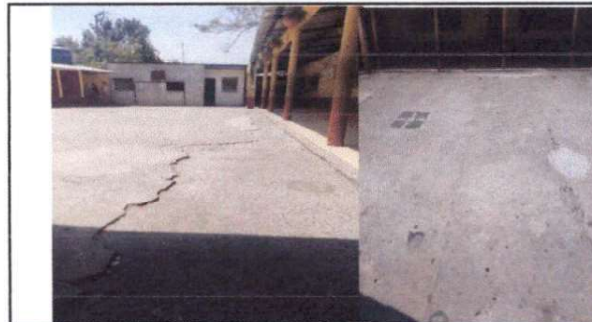
Foto 4: Arreglo de la losa de patio del area de juego de los alumnos
