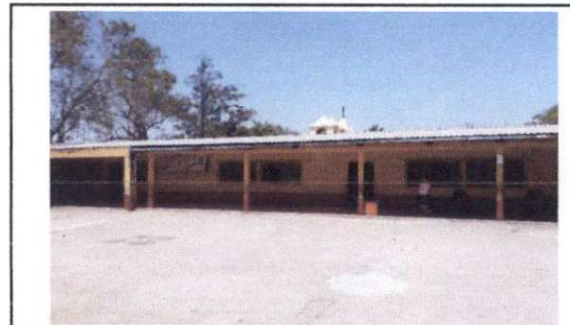
Foto 4: Tambien se realizara aplicacion de pintura en el modulo 2
