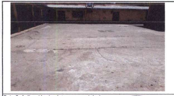
Foto 5: Aplicación de pintura en modulo 1
