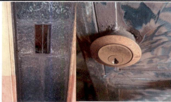
Mantenimiento de puertas de metal y cambio de chapas
