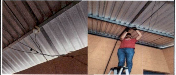
Instalación de fotos y reparación de cableado eléctrico
