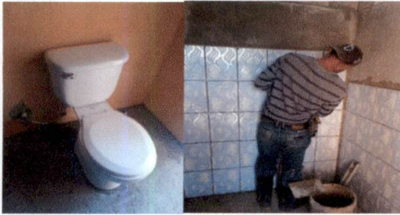
Instalación de piso y azulejo en sanitario de docentes
