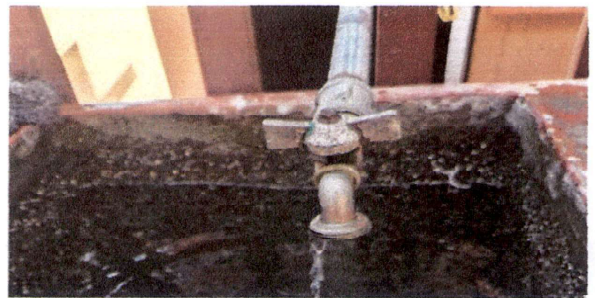
Sustitución de chorros
