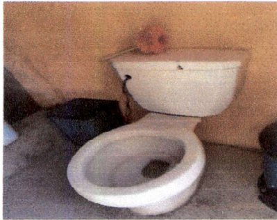
Instalación de piso y azulejo en sanitario de docentes
