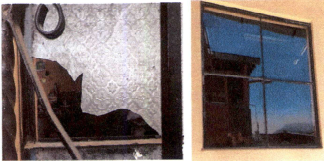
Cambio de vidrios e instalación de balcones
