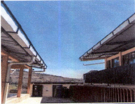
Instalación de lámina troquelada calibre 26 alucinc en patio
