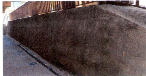
Sustitución de muro de cemento por muro de block
