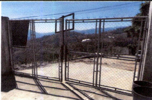
Sustitución de portón de maya por portón de metal
