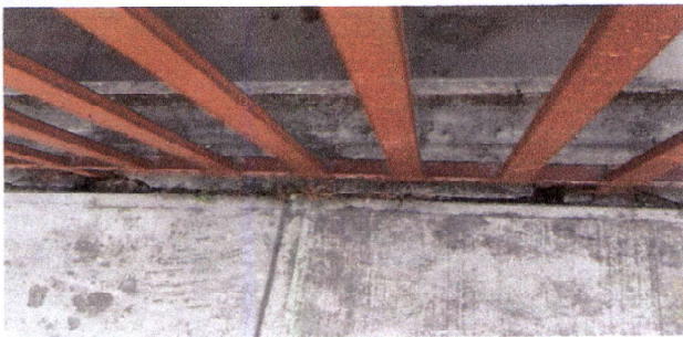
Mantenimiento a barandales
