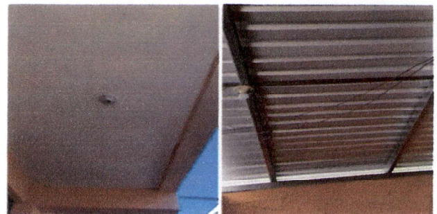
Instalación de focos y reparación de cableado eléctrico
