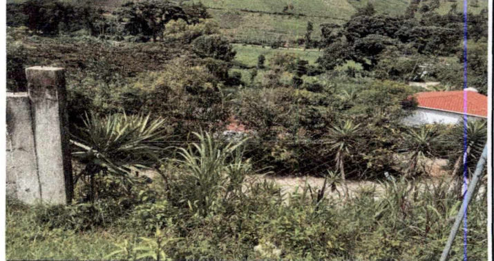
Foto 2: Instalación de tubos hg y malla galvanizada
