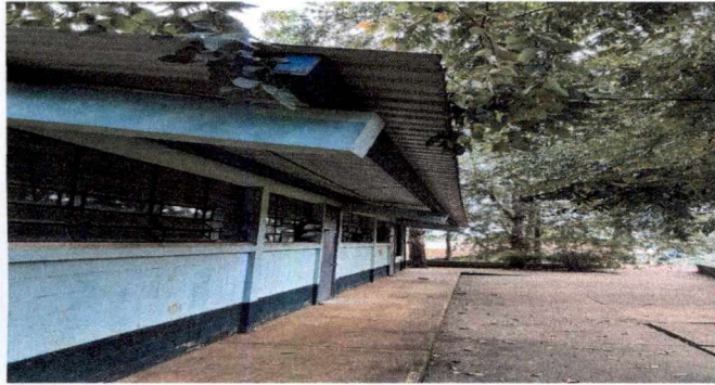
Foto1: Canales y Bajadas de Agua
