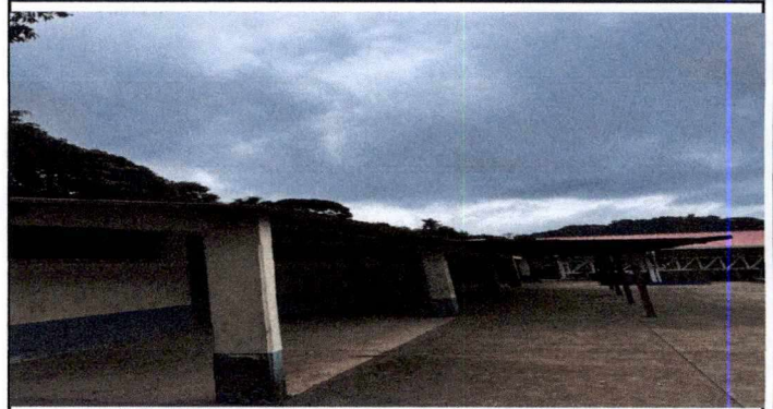
Foto 2: Canales y Bajadas de Agua
