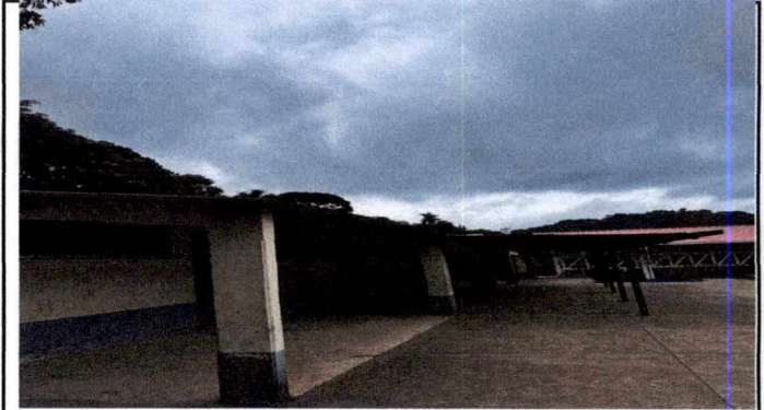
Foto 2: Pintura de Muros Exteriores e Interiores
