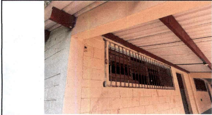
Foto1: Pintura de Muros Exteriores e Interiores
