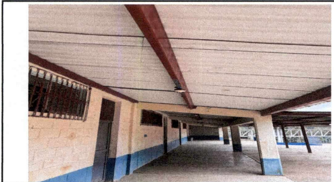
Foto 3: Reparación del Sistema Eléctrico
