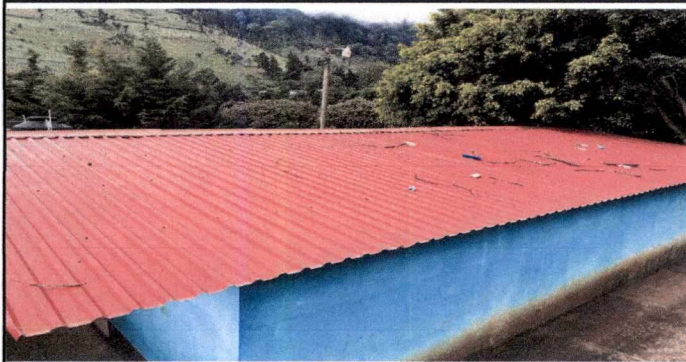
Foto 3: Canales y Bajadas de Agua
