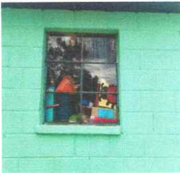
Foto 9: Aula de párvulos donde se sustituyó vidrios al atrás.
