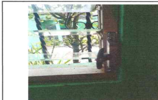
Foto 4: Cambio de operador en ventanas de las aulas de segundo y tercero primaria. Mantenimiento a marcos de aluminio mill finish y se colocaran vidrio(paletas).
