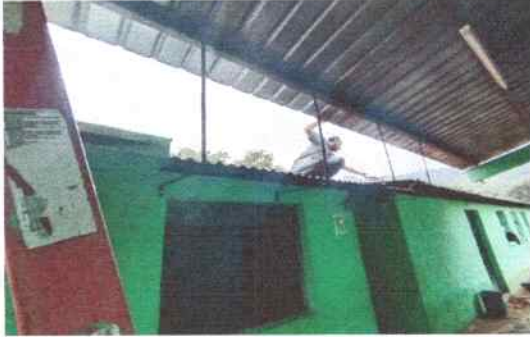
Foto 19: Parte de enfrente del aula de primero primaria, colocando canales y bajadas de agua pluvial.
