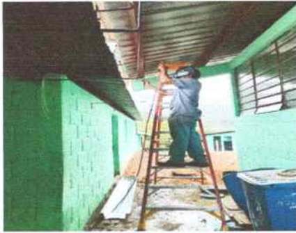
Foto 21: Parte de enfrente del aula de primero primaria, colocando canales y bajadas de agua pluvial.
