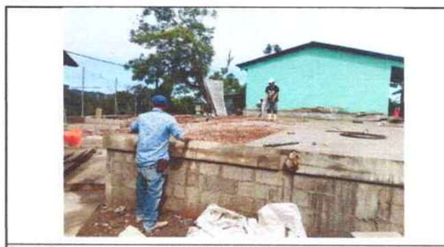
Foto 48: Fundición de planchas de concreto (losa de patio)
