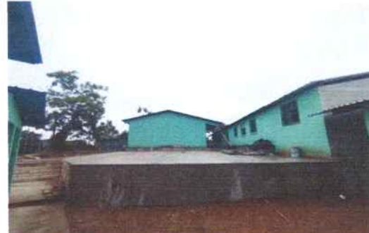
Foto 52: Fundición de planchas de concreto (losa de patio) y tallado de muro.
