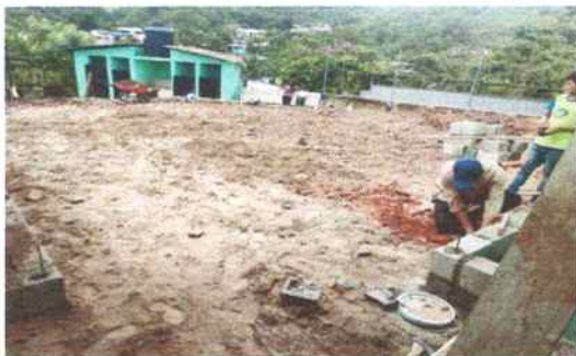
Foto 35: Preparación del suelo y construcción de banca para reforzar la pared del aula de primero y para que se sienten los alumnos.
