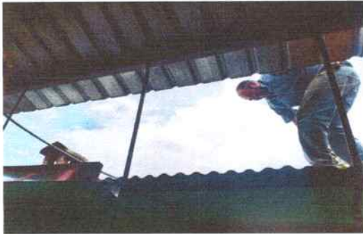
Foto 31: Instalación de pescantes para luego colocar los canales metálicos y bajadas de pvc.
