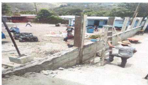
Foto 10: Muro perimetral: donde se tiene previsto la Sustitución de balcones de metal, pintura interior y exterior. Se está arreglando la base del muro donde van a colocarse los balcones y se está realizando cerrido a la parte de columnas y base.
