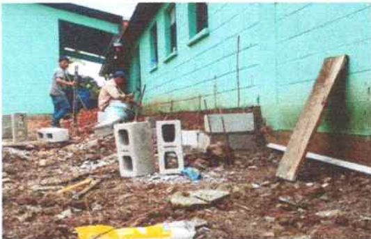
Foto 33: Preparación del suelo y construcción de banca para reforzar la pared del aula de párvulos y para que se sienten los alumnos.
