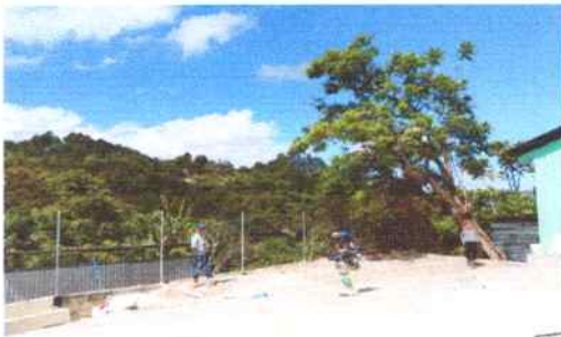
Foto 53: Fundición de planchas de concreto (losa de patio)
