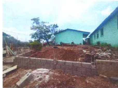
Foto 28: Preparación del suelo y construcción de muro para nivelar la tierra.
