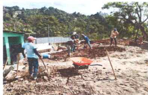
Foto 36: Preparación del suelo para nivelar la tierra.
