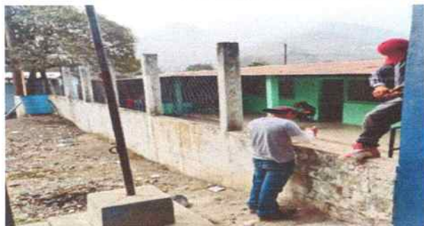
Foto 9: Muro perimetral: donde se tiene realizará la Sustitución de balcones de metal, pintura interior y exterior. Estan quitando la malla.
