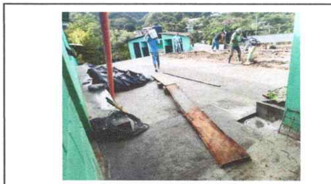
Foto 46: Fundición de planchas de concreto (losa de patio)
