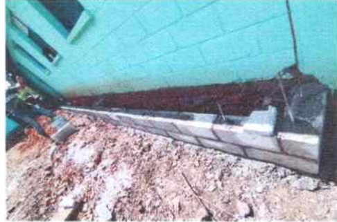
Foto 34: Preparación del suelo y construcción de banca para reforzar la pared del aula de párvulos y para que se sienten los alumnos.
