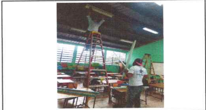
Foto 55: Reparación e instalació de lámparas de dos tubos cada una en aula de primero primaria.
