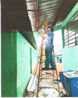
Foto 25: Instalación de pescantes para luego colocar los canales metálicos y bajadas de pvc.
