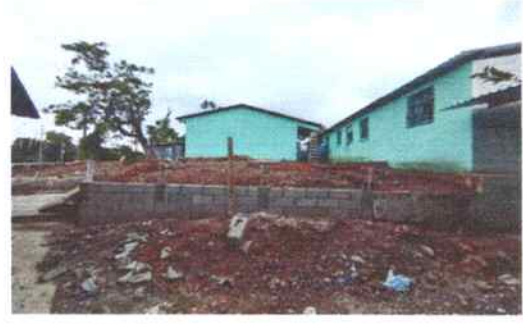
Foto 24: Preparación del suelo para losa de patio en área recreativa.
