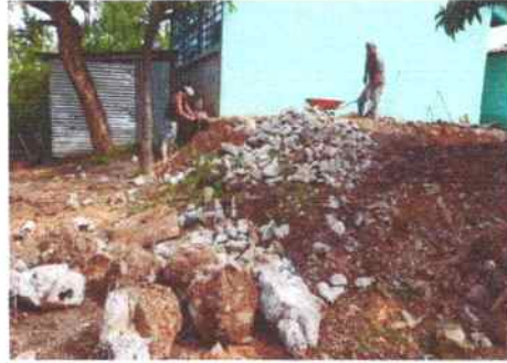
Foto 26: Preparación del suelo y construcción de muro para nivelar la tierra.
