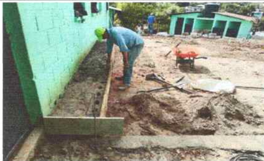
Foto 29: Preparación del suelo y construcción de banca para reforzar la pared del aula y para que se sienten los alumnos.
