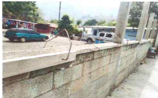
Foto 12: Muro perimetral: donde se tiene previsto la Sustitución de balcones de metal, pintura interior y exterior. Se está arreglando la base del muro donde van a colocarse los balcones y se está realizando cerrido a la parte de columnas y base.
