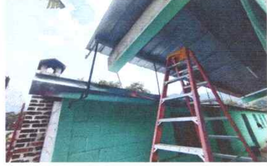
Foto 20: Parte de enfrente del aula de primero primaria, colocando canales y bajadas de agua pluvial.
