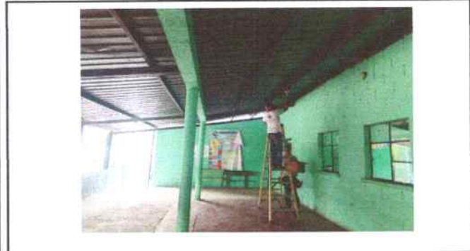
Foto 57: Sustitución de focos ahorradores aulas de párvulos, segundo, tercero, cuarto y corredores.
