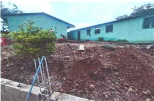
Foto 23: Preparación del suelo para losa de patio en área recreativa.
