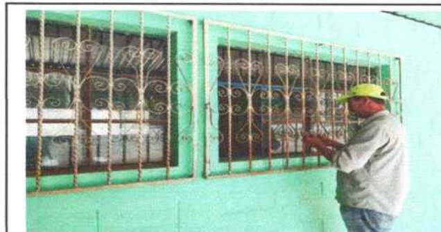
Foto 6: Aula de Segundo y tercero Primaria donde se realiza mantenimiento de balcones y ventanas. (lijado y limpieza de balcones).
