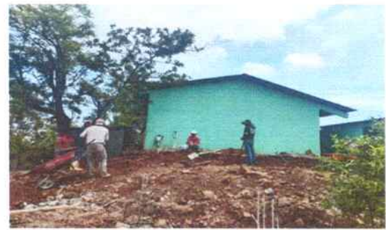
Foto 22: Preparación del suelo para losa de patio en área recreativa.
