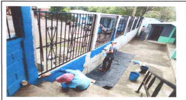
Foto 16: Muro perimetral: pintura interior.
