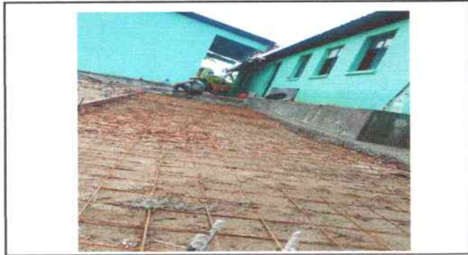
Foto 43: Fundición de planchas de concreto (losa de patio)
