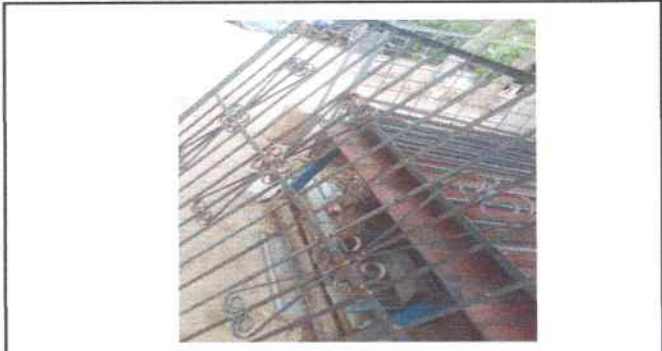
Foto13: Elaboración de balcones para colocar en muro perimetral.
