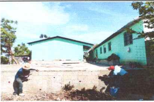
Foto 51: Fundición de planchas de concreto (losa de patio) y tallado de muro.
