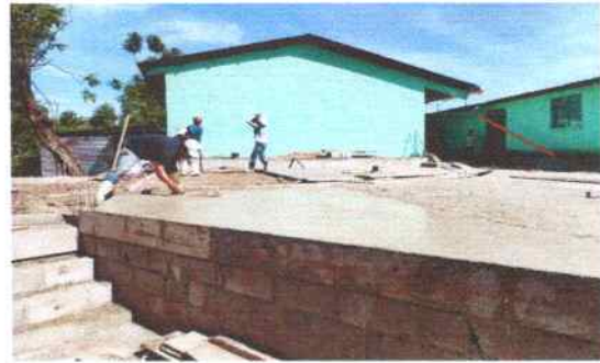
Foto 50: Fundición de planchas de concreto (losa de patio)
