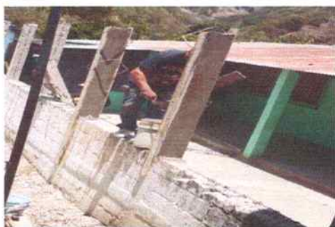
Foto 11: Muro perimetral: donde se tiene previsto la Sustitución de balcones de metal, pintura interior y exterior. Se está arreglando la base del muro donde van a colocarse los balcones y se está realizando cerrido a la parte de columnas y base.
