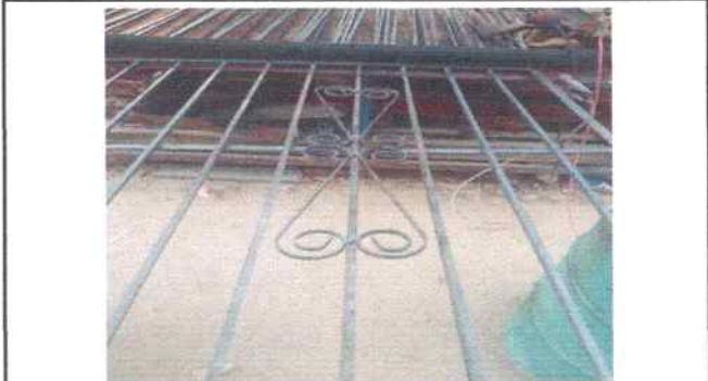
Foto 14: Elaboración de balcones para colocar en muro perimetral.
