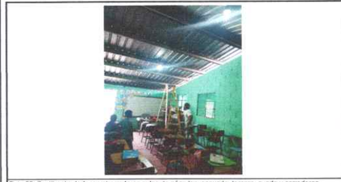
Foto 59: Sustitución de focos ahorradores aulas de párvulos, segundo, tercero, cuarto y corredores.
