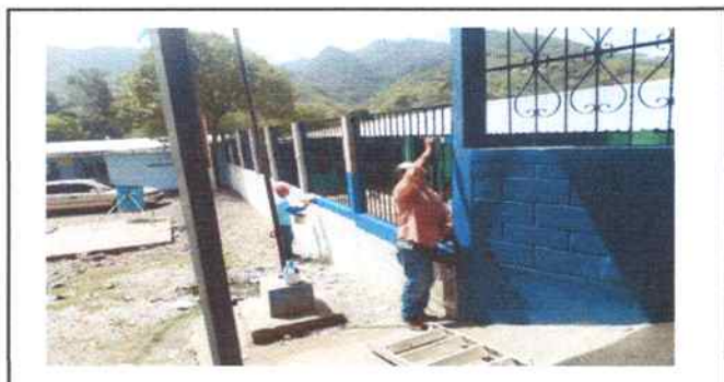
Foto 17: Muro perimetral: pintura exterior.
