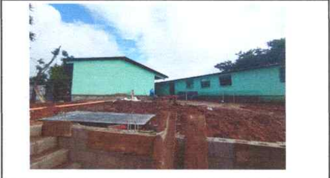
Foto 40: Preparación del suelo para colocar las electromallas para reforzar las planchas de concreto.
