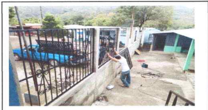
Foto 15: Muro perimetral: colocación de balcones de metal.
