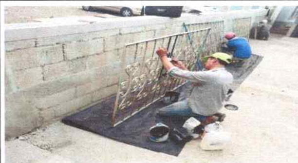
Foto 8: Mantenimiento a los balcones, pintando balcones del módulo de las aulas de segundo y tercero.
