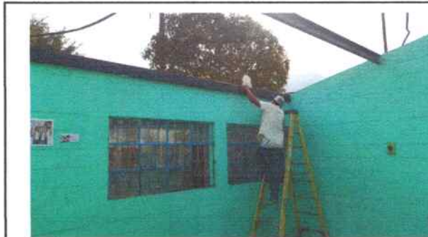
Foto 2: Mantenimiento a estructura de soporte de metal ) limpiado, lijado, pintada, sustitución de secciones de costanera) módulo de las aulas de Segundo y tercero primaria.
