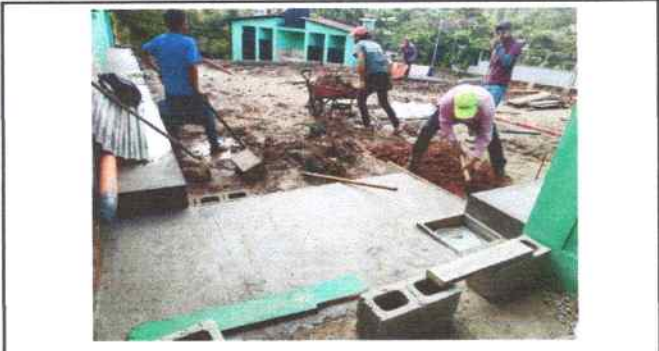
Foto 37: Preparación de suelo para fundir planchas de concreto
