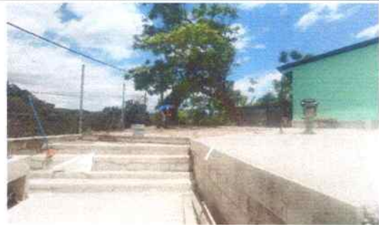
Foto 54: Fundición de planchas de concreto (losa de patio)
