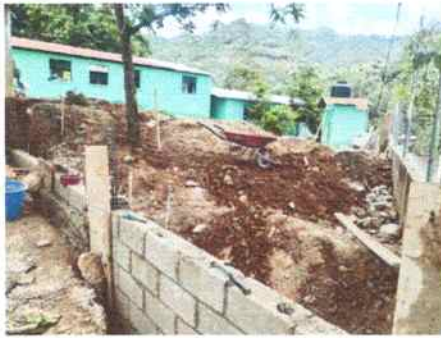
Foto 27: Preparación del suelo y construcción de muro para nivelar la tierra.
