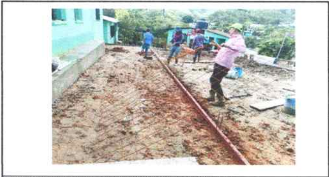
Foto 42: Colocación de electromalla para reforzar las planchas de concreto
