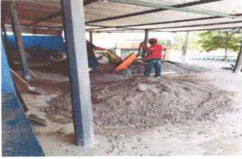
Foto 49: Preparación de material para fundir planchas de concreto (losa de patio)
