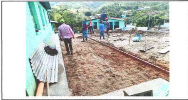
Foto 41: Colocación de electromalla para reforzar las planchas de concreto.
