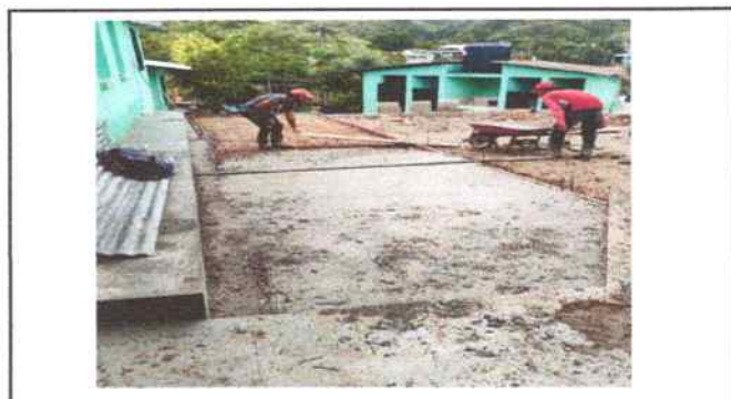
Foto 45: Fundición de planchas de concreto (losa de patio)
