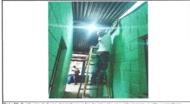
Foto 60: Sustitución de focos ahorradores aulas de párvulos, segundo, tercero, cuarto y corredores
