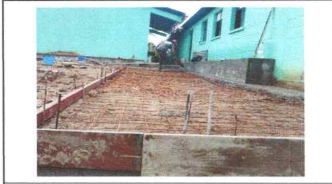
Foto 44: Fundición de planchas de concreto (losa de patio)
