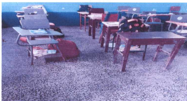
Foto 6: Sustitución de piso por piso cerámico. El piso está muy deteriorado, ya sin color.
