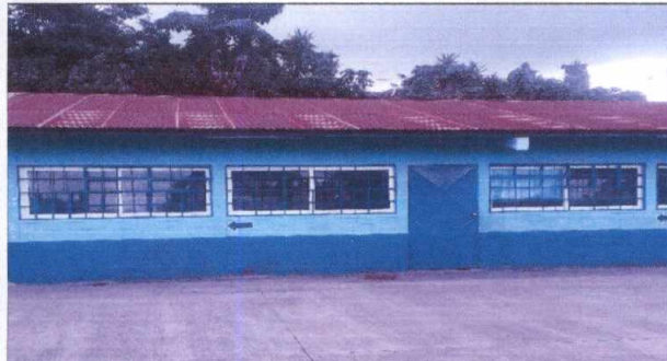
Foto1: Sustitución de lámina por lámina troquelada y sustitución de capote, ya que la lámina y capote están deteriorados.
