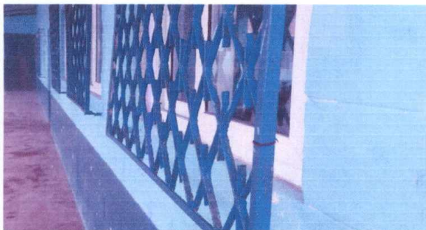
Foto 5: Instalación de balcones de metal. Los balcones existentes están muy grandes y están deteriorados, por lo que se necesita que los balcones esten a la medida de cada ventana.
