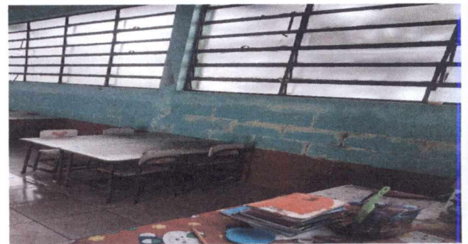
Foto 4: Pintura en paredes exteriores e interiores de la escuela.
