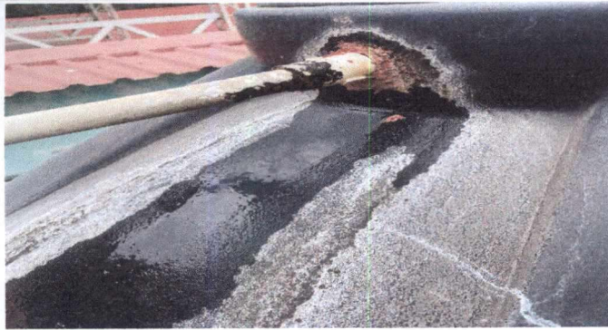
Foto 1: Reparación de depósito de agua en área de sanitarios.
