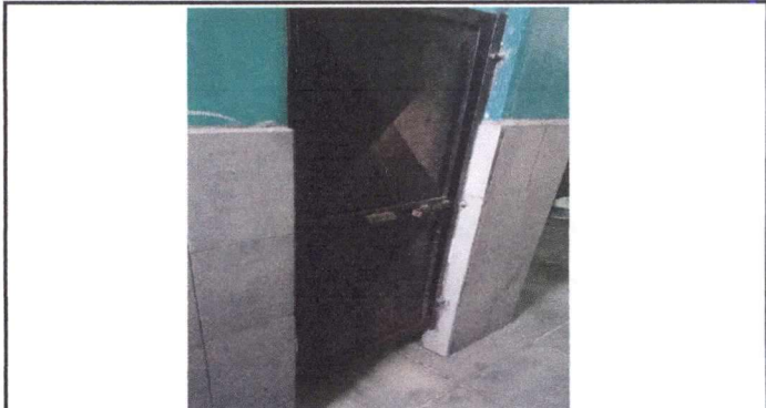
Foto 4: Reparación y mantenimiento de puertas de metal en área de sanitarios
