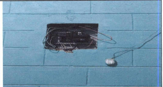
Foto 2: Sustitución de Tablero eléctrico.
