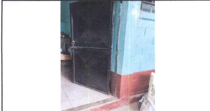
Foto 1: Reparación y mantenimiento de puertas de metal en aulas
