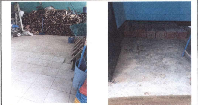
Foto 2: Instalación de piso cerámico en aula
