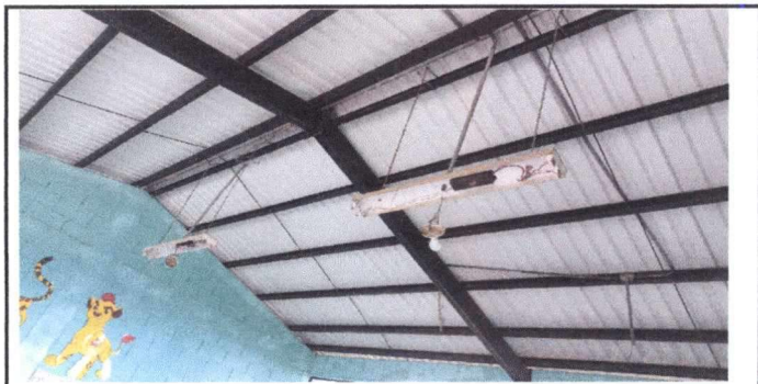
Foto 6: Sustitución de lámparas con cableado, ducto y accesorios
