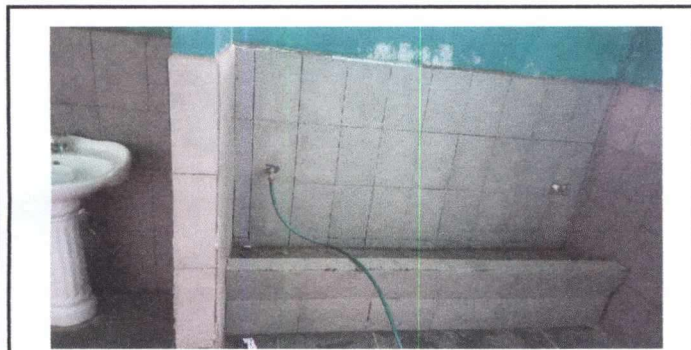
Foto 5: Sustitución de mingitorios por mingitorios de porcelana e instalación de sistema de drenaje
