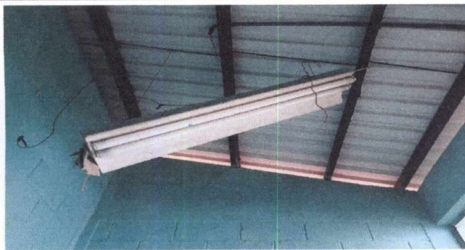
Foto 3: Sustitución de lámparas con cableado, ducto y accesorios.
