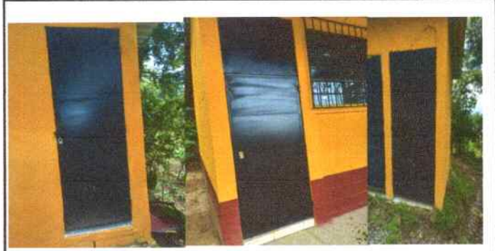
Foto 2: sustitución de puertas 3 aulas y 2 puertas de sanitarios incluye sobremarcos, y chapas yale.
