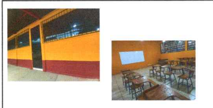
Foto 4: pintura interiores y exteriores
