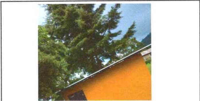
Foto 1: sustitución de lámina por lámina troquelada aluzinc calibre 26 en techo del baño.
