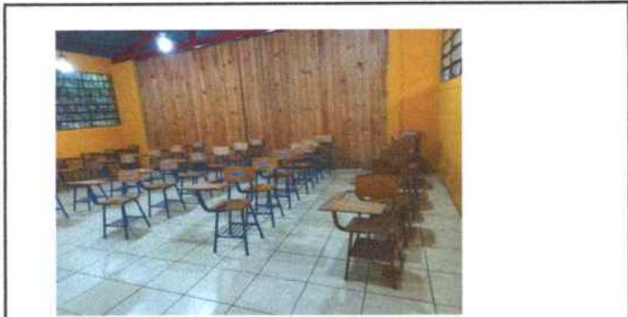
Foto 3: Intalación de piso antideslizante en 3 aulas.
