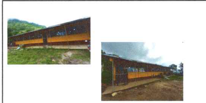
Foto 6: Intalación de maya para proteger puertas.
