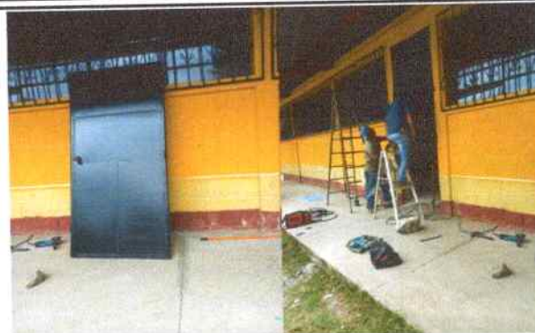
Foto 2: sustitución de puertas 3 aulas y 2 puertas de sanitarios incluye sobremarcos, y chapas yale.
