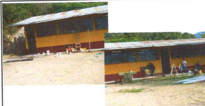
Foto 4: pintura interiores y exteriores
