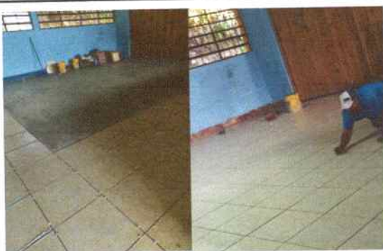
Foto 3: Intalación de piso antideslizante en 3 aulas.
