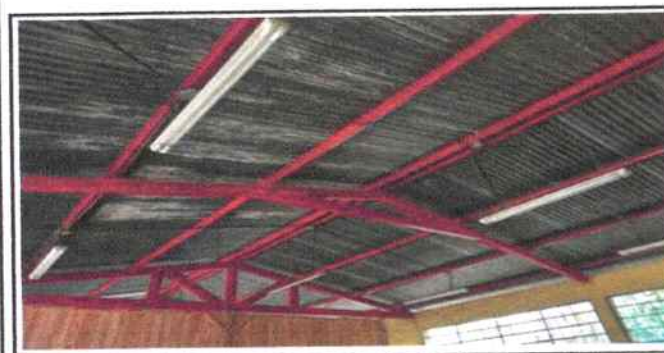
Foto 5: Sustitución de lamparas tipo LED, incluye lamparas rectangulaes, plafonera y revisión de todo el sistema eléctrico.
