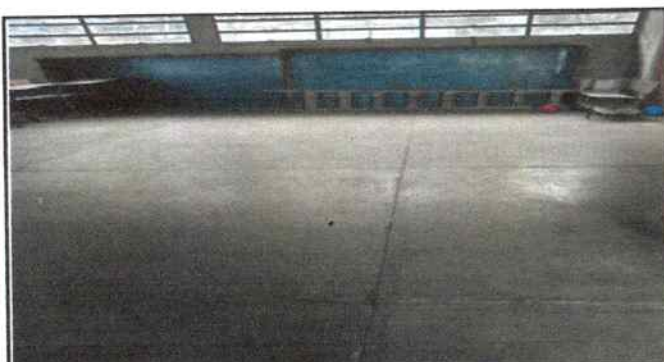
Foto 3: Intalación de piso antideslizante en 3 aulas.
