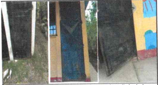
Foto 2: sustitución de puertas 3 aulas y 2 puetas de sanitarios incluye sobremarcos, y chapas yale.
