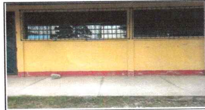
Foto 4: pintura interiores y exteriores
