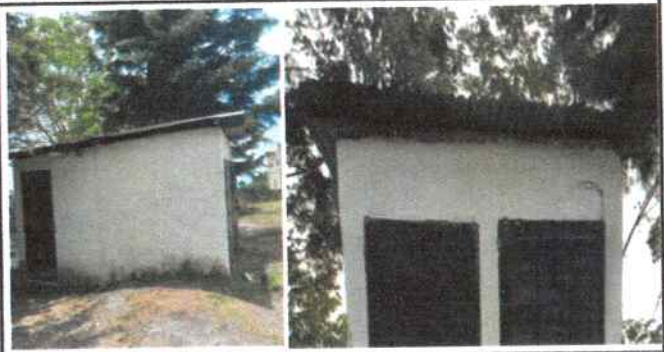
Foto1: sustitución de lámina por lámina troquelada aluzinc calibre 26 en techo del baño.
