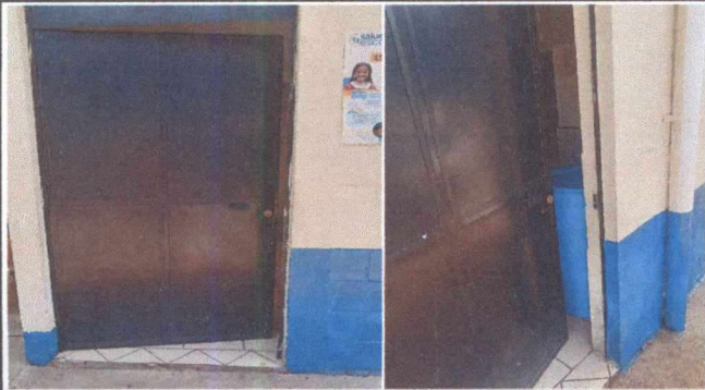
Foto 1: Se muestra las imágenes del estado de las puertas ubicadas en los 3 módulos del establecimiento educativo, donde las mismas recibirán mantenimiento.
