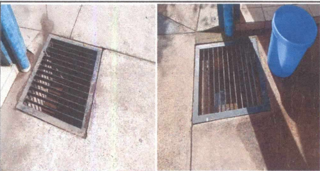
Foto 5: Mejoramiento a las cajas de registro de bajadas de agua pluvial con lámina desplegada para evitar el ingreso de partículas.
