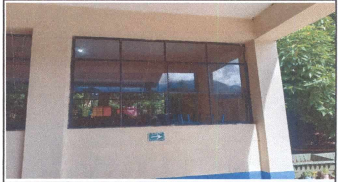
Foto 2: Se muestra la imagen correspondiente al módulo 1, en la misma se hará fabricación e instalación de balcones, según las medidas establecidas.
