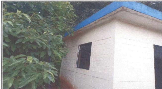
Foto 3: Se muestran el módulo que se utiliza para cocina, en el mismo se tiene contemplado realizar tres ventanas tipo sifón, para dar mejor ventilación al mismo.
