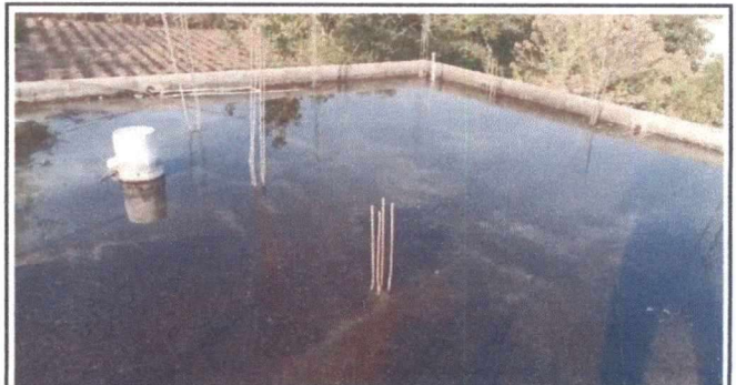
Foto 6: Espacio destinado para la instalación de tinaco con capacidad de 1700 litros y la colocación de estructura metálica para su resguardo.
