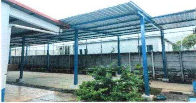
FOTO 1: SUSTITUCIÓN DE ESTRUCTURA PORTANTE DE METAL Y LÁMINA TROQUELADA CALIBRE 26
