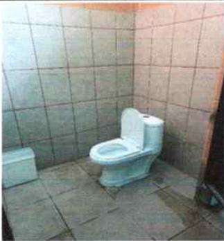
FOTO 3: INSTALACIÓN DE DOS SANITARIOS TIPO BABY EN SERVICIOS SANITARIOS
