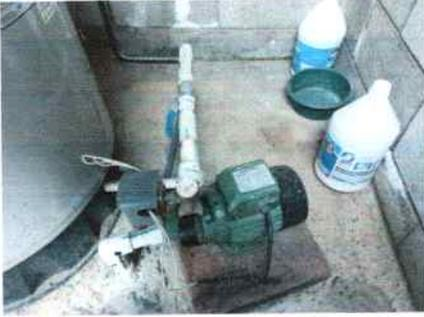
FOTO 7: SUSTITUCIÓN DE BOMBA CENTRÍFUGA DE 1HP
