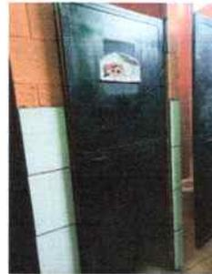
FOTO 6: INSTALACIÓN DE PUERTA DE METAL EN SERVICIOS SANITARIOS
