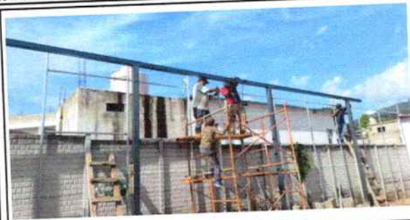
Fotografía :1 se muestran los avances del techado del patio central, colocando nuevas bases de soporte de metal.
