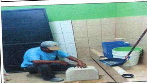
Foto:3 se muestra al plomero encargado de sustituir los accesorios en los tanques de los sanitarios .
