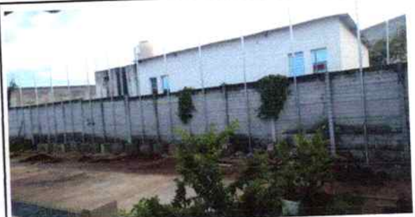
Foto:4 se muestran os vances en la colocación de tubo galvanizado en el refuerzo del muro perimetral.
