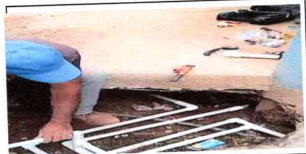
Foto:6 colocación de nueva tubería para el sistema de agua potable que proviene de la bomba de agua y abastece a toda la escuela.
