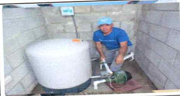
Foto :5 se muestra la colocación de la nueva bomba Centrífuga .
