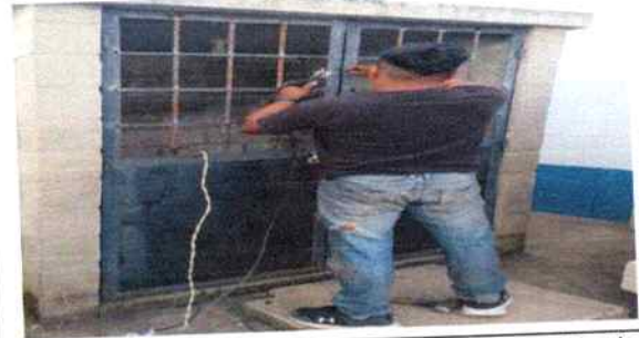
Foto:2 se muestra el refuerzo de la puerta donde se encuentra la bomba, esta esta siendo reforzada para colocarle nuevos candados, pasadores , también volviendo su reja mas resistente .
