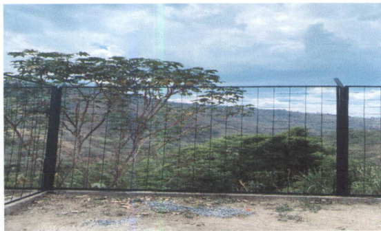
Foto 9: Instalación de electro malla.
