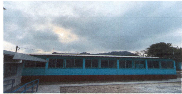
Foto 2: Vista del patio trasero enfrente del aula de parvulos, carrilera finalizada.
