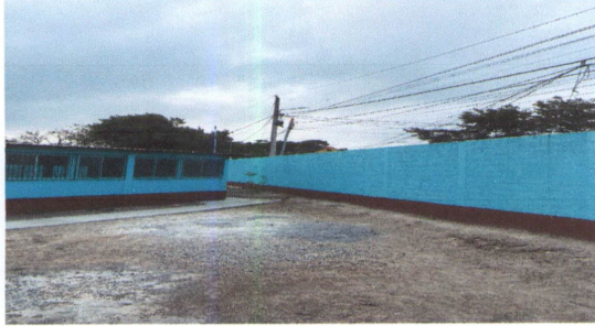
Foto 7: Pintura en el muro exterior
