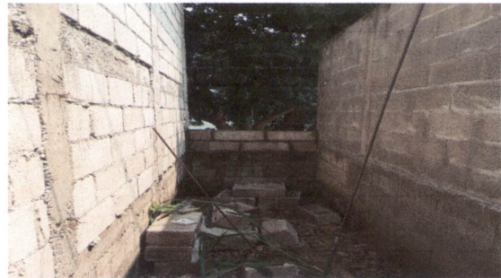
Foto 4: Vista de la pared de afuera de las aulas.
