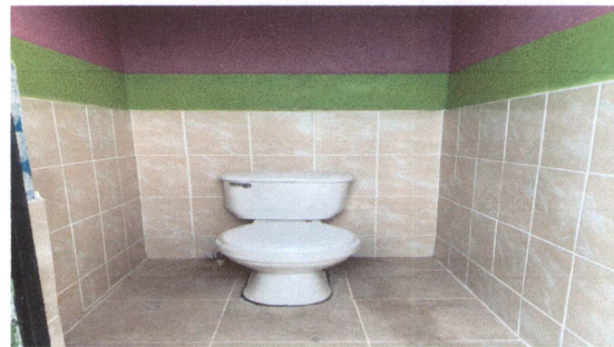
Foto 6: Instalación de sanitarioa del establecimiento
