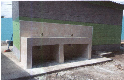
Foto 5: Instalación de lavamanos con plancha de concreto
