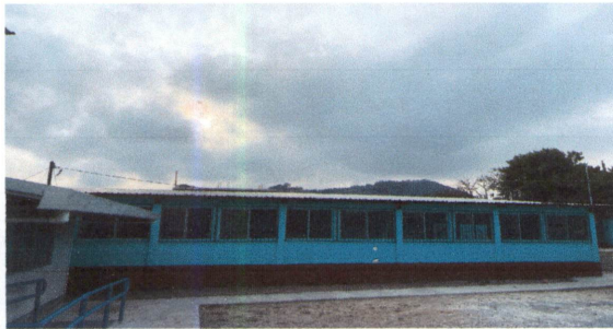
Foto 3: Instalación de balcones en todas las aulas.
