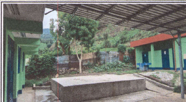
Foto 2: Ampliación de fabricación de techo de 92 mts cuadrados, ubicados del esenario al módulo de sanitarios de la escuela
