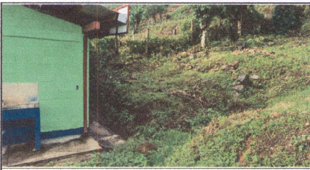
Foto 6: Protección exterior para muro posterior de sanitarios: Incluye electromalla + aplicación de savieta
