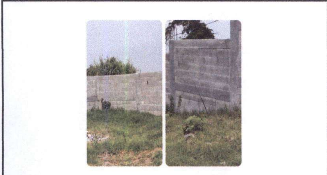
Foto 7: Módulo 1. En este espacio se puede observar que es un terreno rústico el cual necesita torta de cemento para poder funcionar como bodega.
