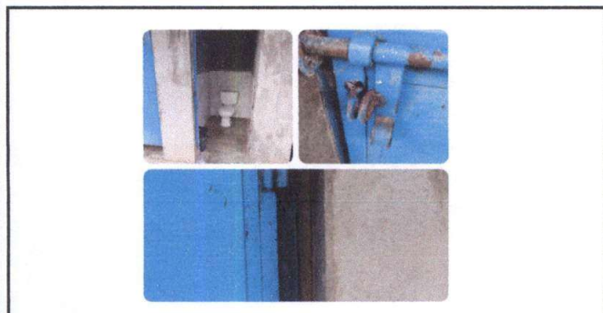
Foto 5: Módulo 3. Se puede observar el mal estado de las puertas de los sanitarios y una puerta que se desprendió de sulugar. La puertas necesitan ser ancladas y reparadas.
