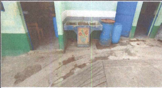
Foto 3: Área de patio, cambio de losa de patio
