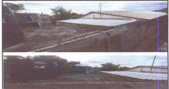
Foto 10: Impermeabilización de losa
