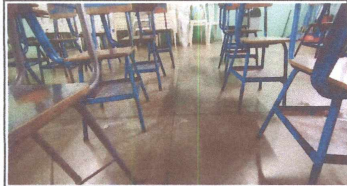
Foto 3: Salón de Clases 2do. B Piso y Pintura
