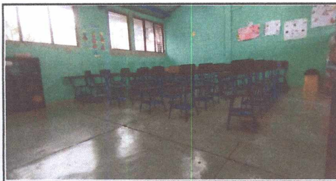
Foto 11: Salón de Clases 1ero. A Piso y pintura
