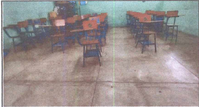
Foto 1: Área Salón de Clases 2do. A Piso y Pintura
