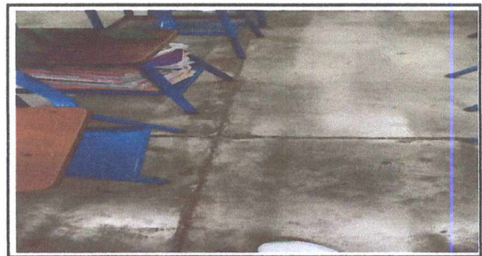
Foto 12: Salón de Clases 1ero. A Piso y Pintura
