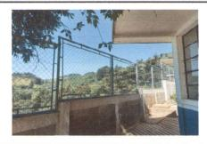
FOTO 1: SUNIMISTRO E INSTALACIÓN DE TUBO HG Y MALLA GALVANIZADA
